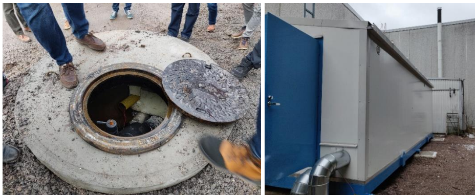
Kuva 8. Espoon Koskelon 1,3 km keskisyvä geoterminen energiakaivo ja lämpöpumppu-laitos. Kuva: Sweco Talotekniikka Oy.
