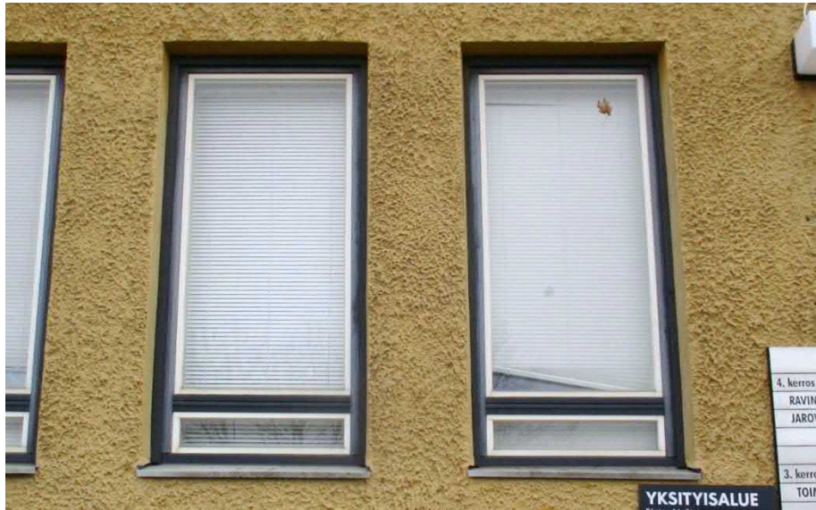
Kuva 40. 1. kerroksen ikkunat Kutomotien puolella.
