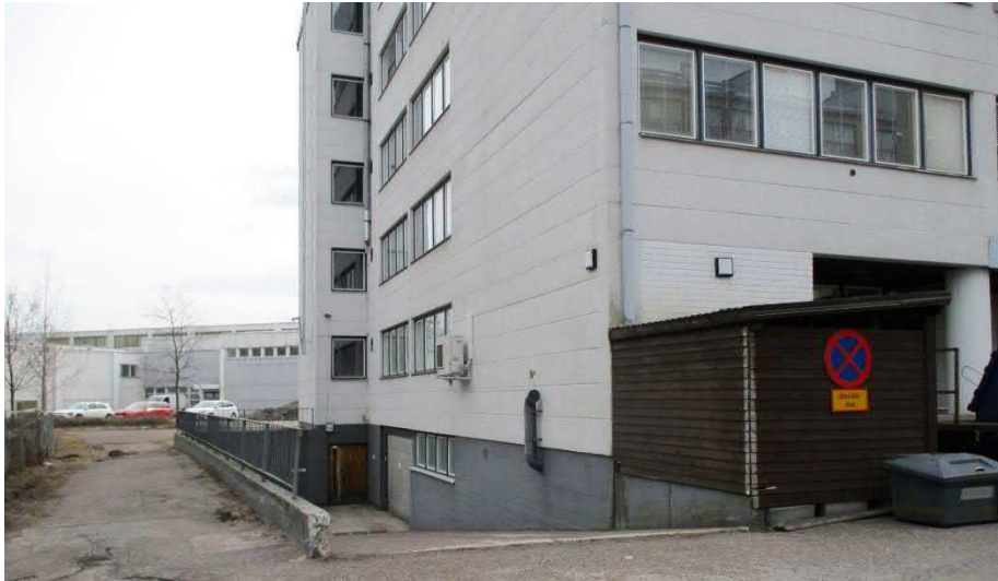
Kuva 80. Luiska kellariin rakennuksen koillispuolella.
