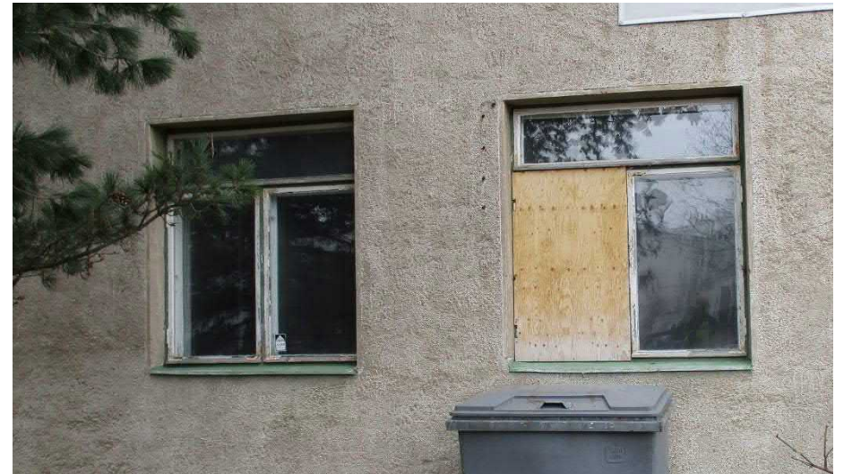
Kuva 63. Vanhan osan ikkunat (1950-luvun alusta).
