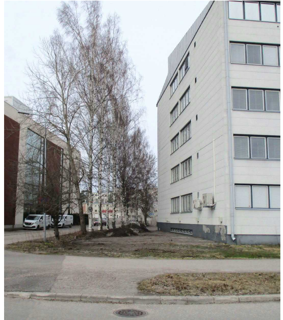
Kuva 78. Kutomokujan itävarsi ja koivurivi, näkymä etelästä. Asemapiirustuksissa tällä kiinteistöosalla on merkitty parkkipaikkoja.
