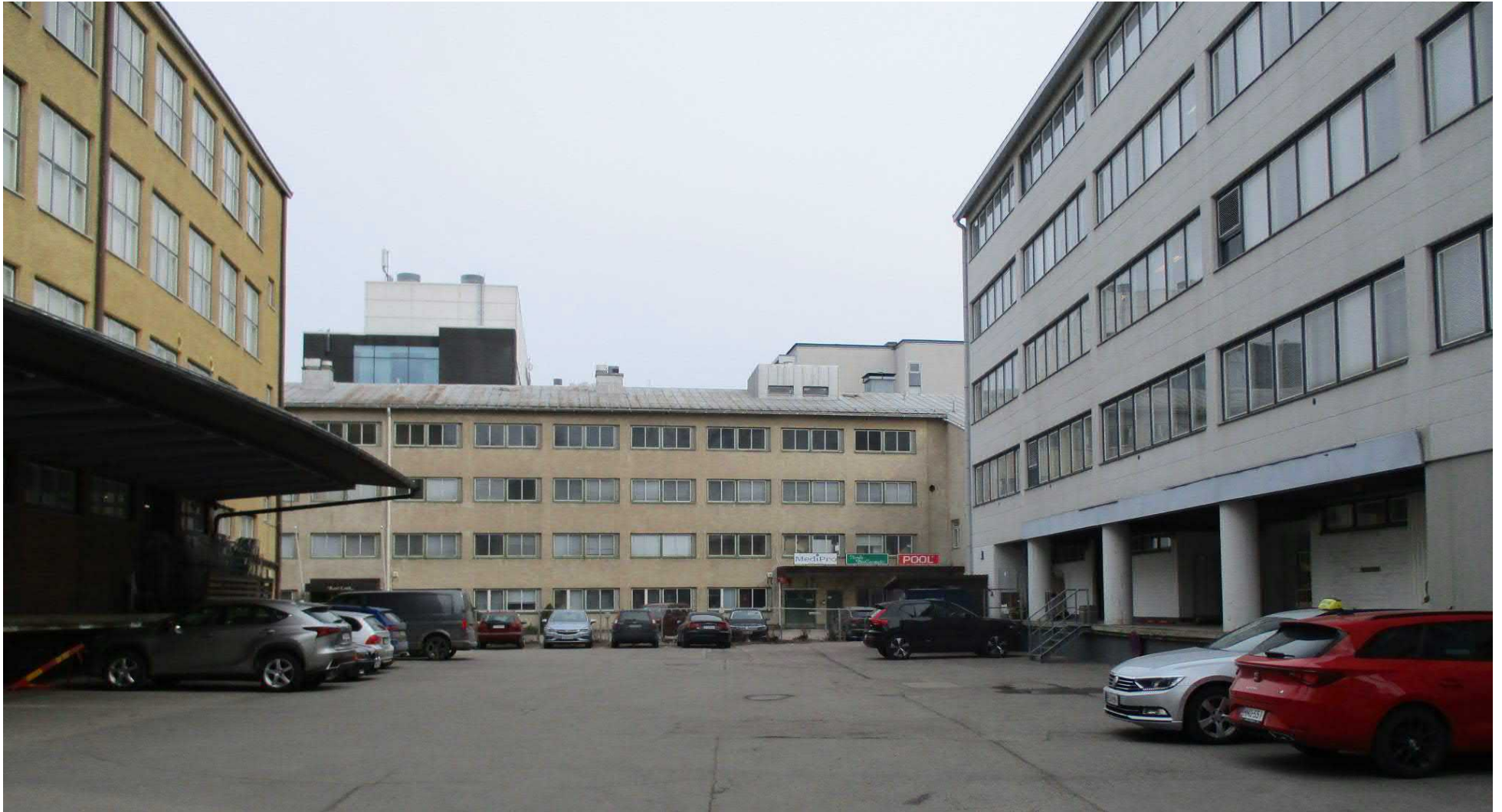
Kuva 54. Näkymä rakennukseen naapuritontin läpi (Kutomotie 6). Kuva otettu Kutomokujalta.
