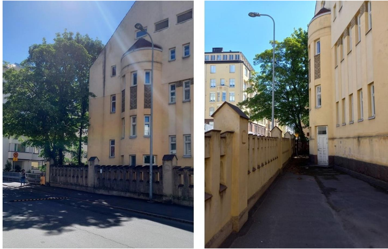
Kuva 69 Marian sairaalan aluetta Lapinlahdenkadun varrella rajaava rapattu tiilimuuri puretaan rakentamisen ajaksi ja rakennetaan uudelleen alkuperäisen toteutuksen mukaisesti. Baanan reunalla oleva vanha vaahtera joudutaan kaatamaan (Ramboll Finland Oy).
