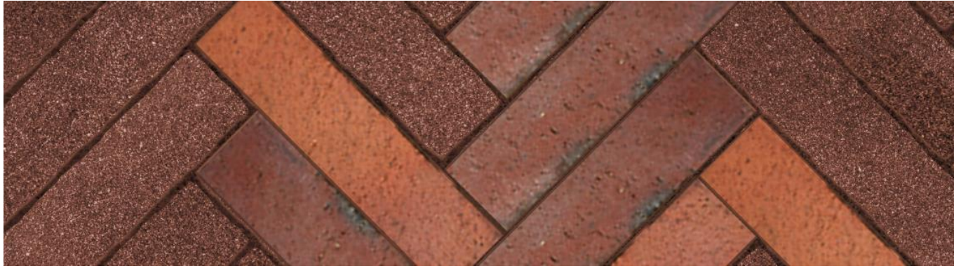
Kuva 49. Jalankulun kiveys tehdään kalanruotoladonnalla tehtävällä maatiilellä. Maatiilen koko esim. 292/71/52, väri punaruskea.
