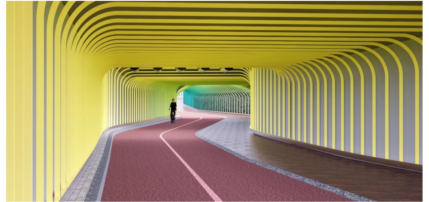
Kuva 43. Näkymä itään. Tunnelijaksolla profiilien väri on toteutettu liukumavärein. Tunnelijaksolla olevat puhaltimet ovat nostettu syvennyksiin tunnelin katossa.
