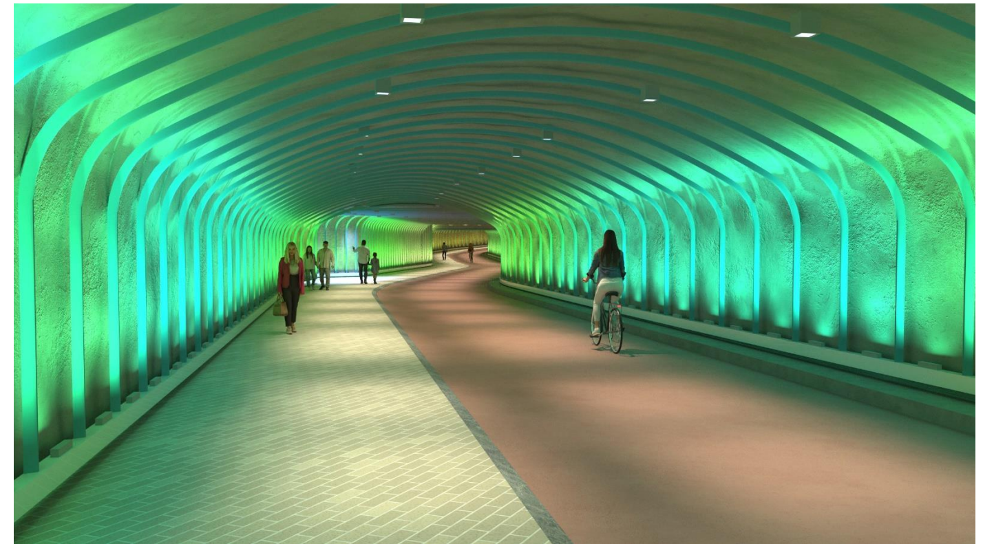
Kuva 52 Mariantunnelin valaistus kalliotunnelista poistumisyhteyteen päin kuvattuna
