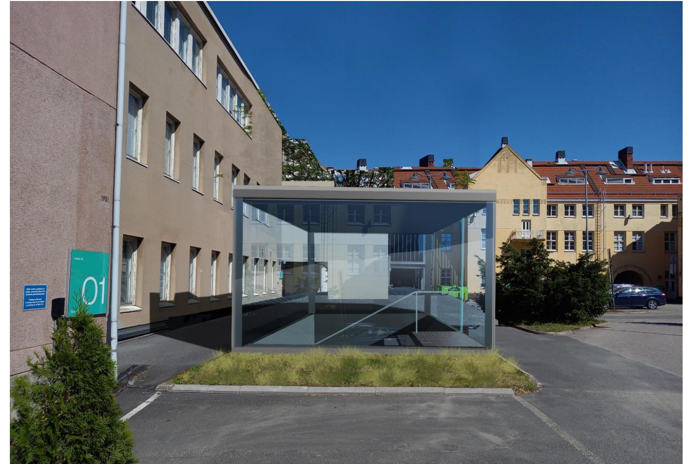
Kuva 47. Tunnelista on yhteys Marianpihalle porraskuilun kautta.
