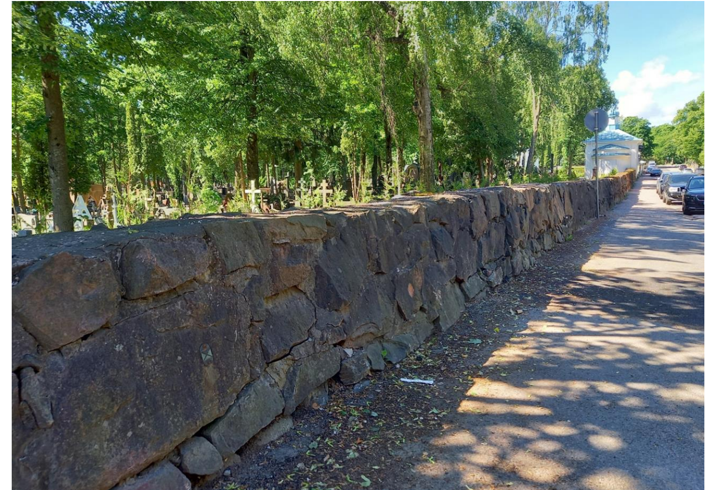
Kuva 68 Ortodoksisen hautausmaan 1800-luvulla rakennettu kivimuri joudutaan purkamaan ja ennallistamaan Mechelininkadun ja Profeetta Elian kappelin väliseltä osuudelta (Ramboll Finland Oy)
