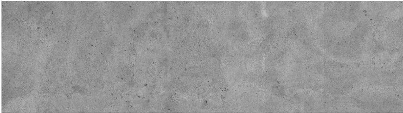
Kuva 50. Paikallavaletut betonipinnat jätetään muottipinnalleen.
