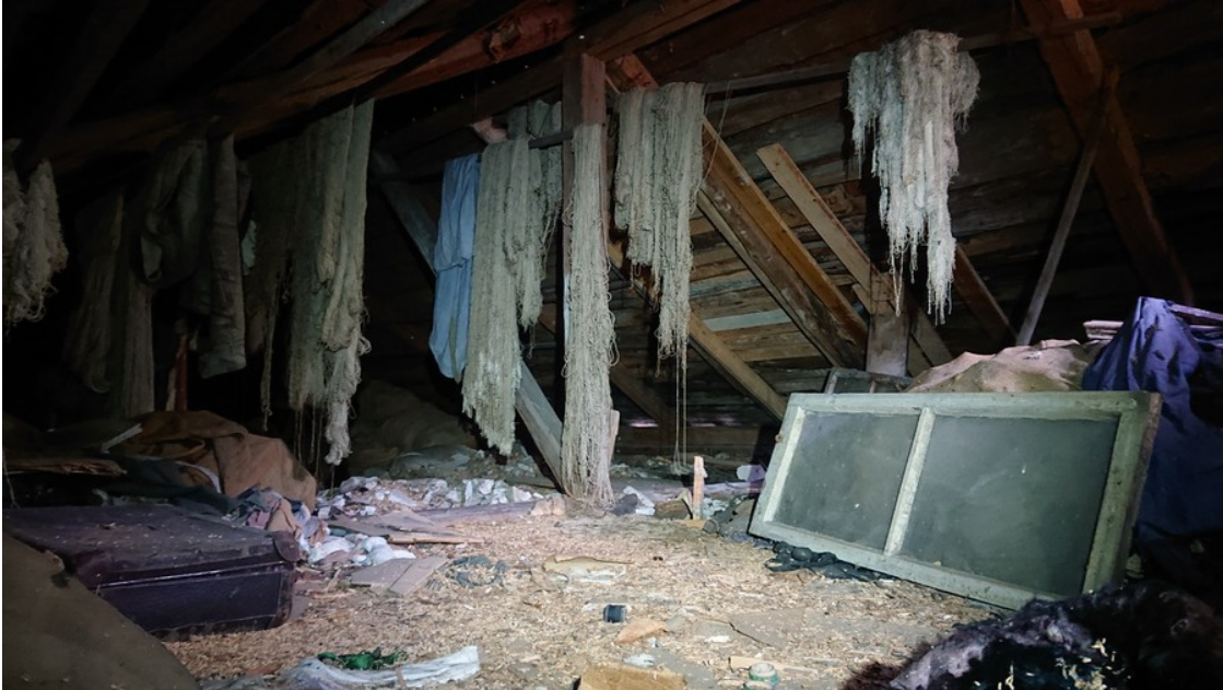
Kuva 6.11. Kalastajatorpan päärakennuksen vintti.
