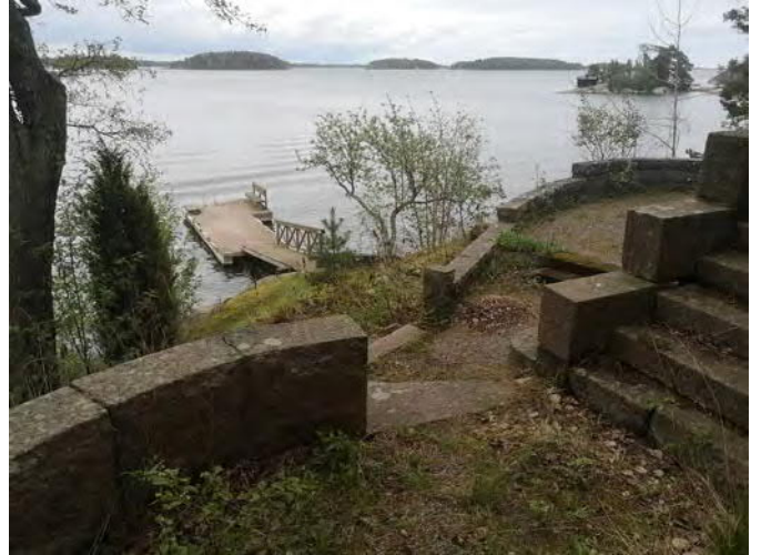
Kuva 33. Villa Svalvikin graniittikivimuureja ja -portaita kevät 2021.
