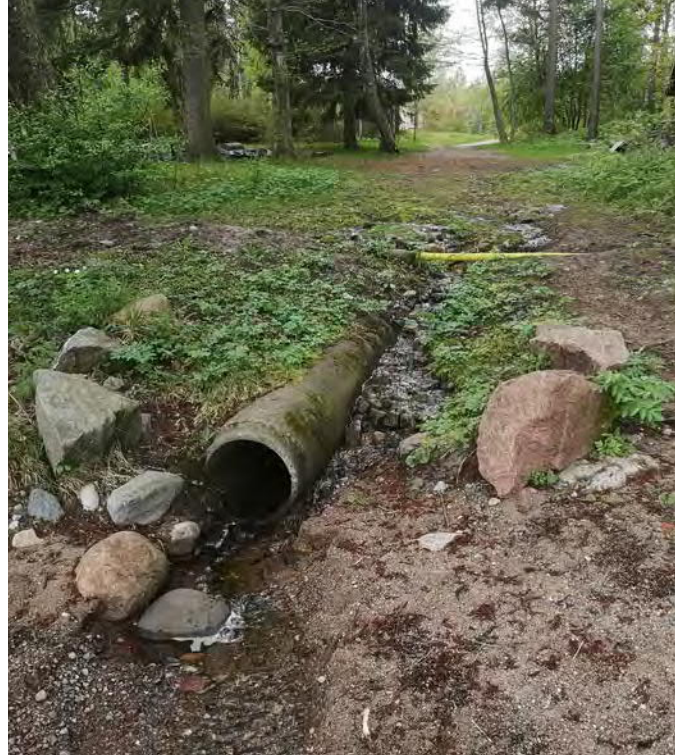
Kuva 89. Puuskakujalta laskeva betoninen hulevesiputki purkaa hiekkarannalle. Kesä 2021.
