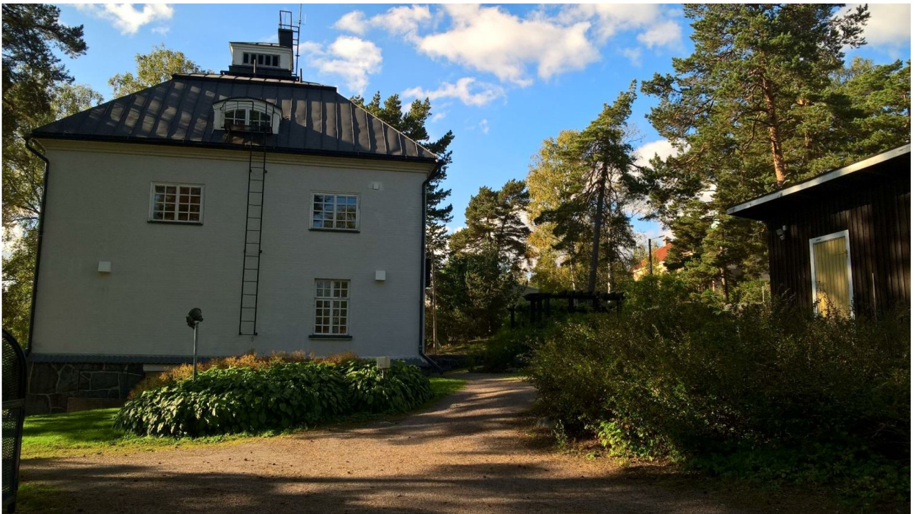
Näkymä tontin itäpuolelta länteen päin Kulosaarentie 42:n pihalle.
