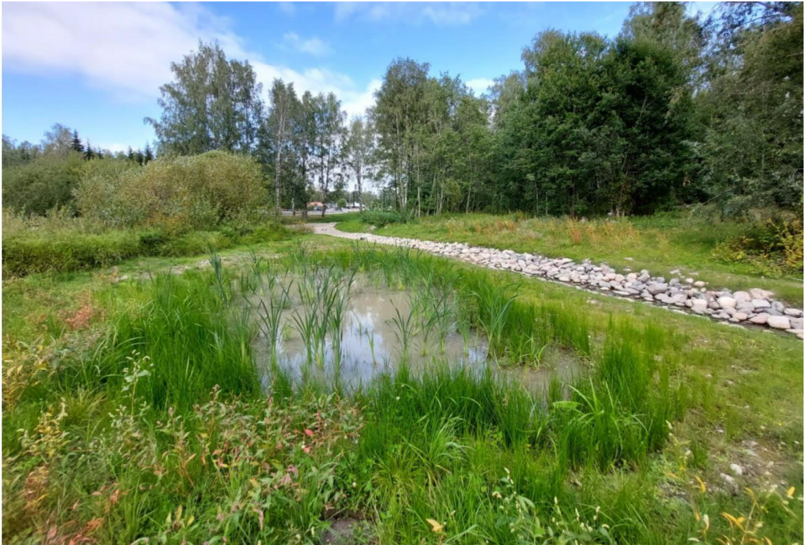
Kuva 3 Referenssikuva kasvipeitteisestä hulevesialtaasta Lampuotilanpuistossa Helsingissä.
