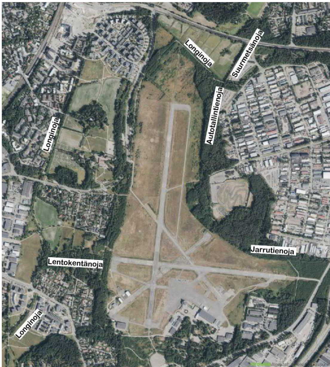
Kuva 1. Ilmakuva Malminkentän alueesta
