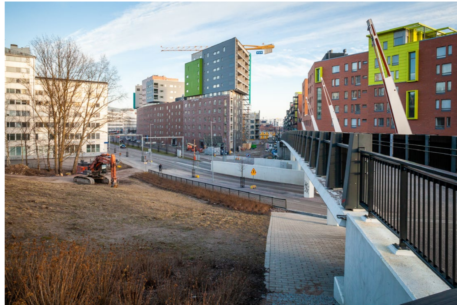
Uusi rakentamisen paikka pohjoisesta, Sähköttäjänpuistosta nähtynä. Pikakaraitiotien viemistä tästä kohtaa maan alle tutkitaan.
