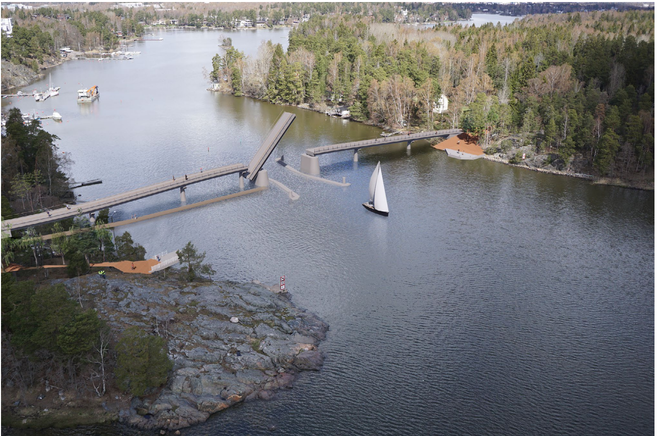
Kuva 43. Avattava läppäsilta ylhäältä päin kuvattuna.
