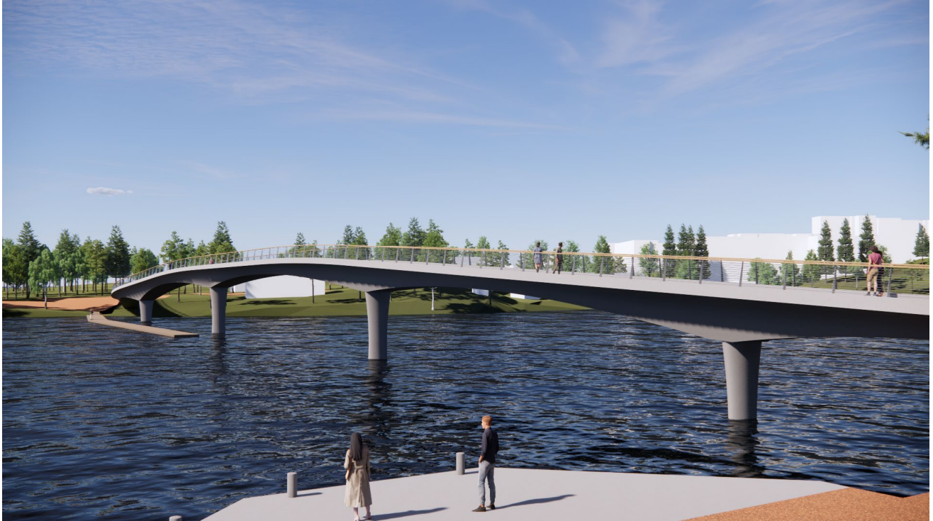
Kuva 36. Betoninen palkkisilta Vartiosaaren puolelta kuvattuna.
