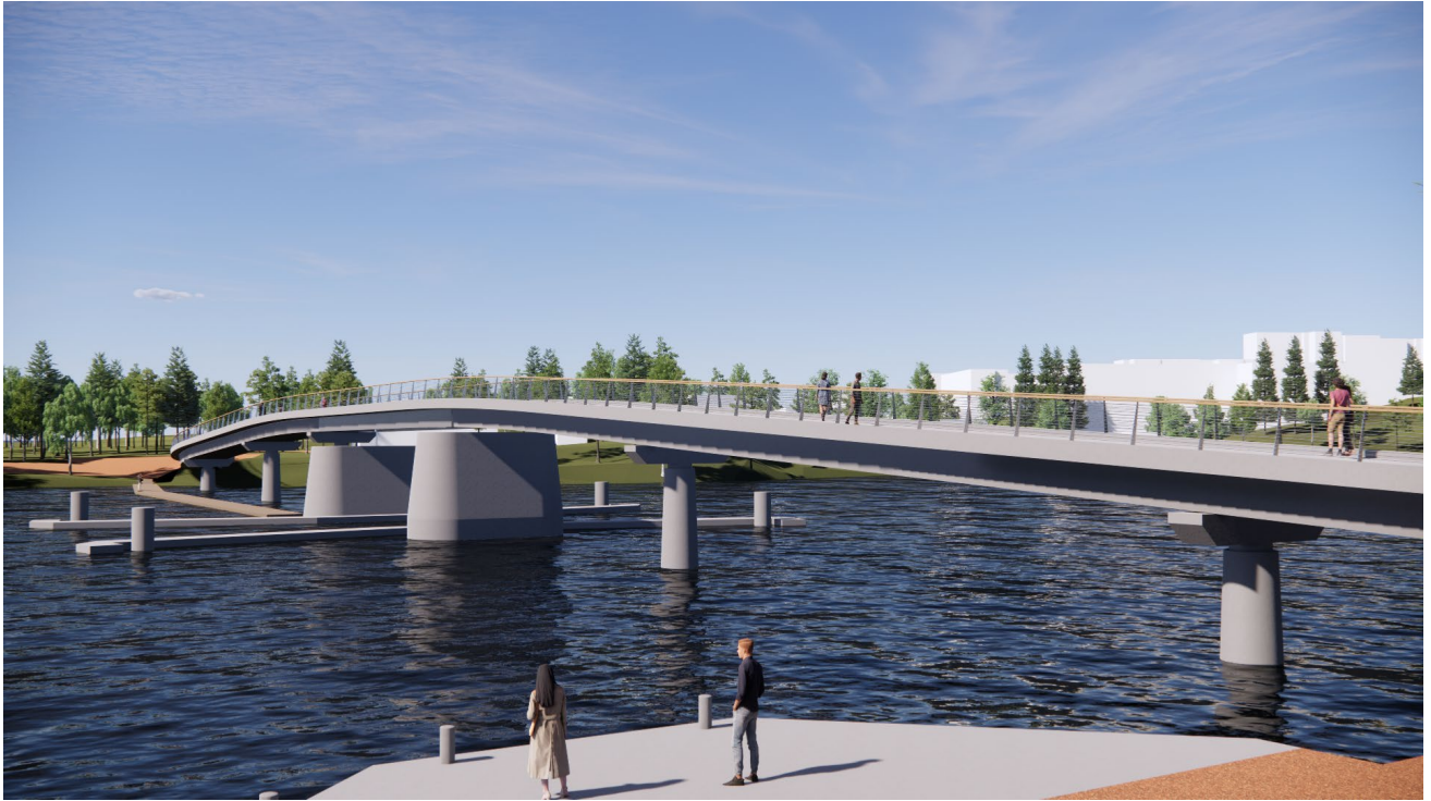
Kuva 44. Avattava läppäsilta Vartiosaaren puolelta kuvattuna.
