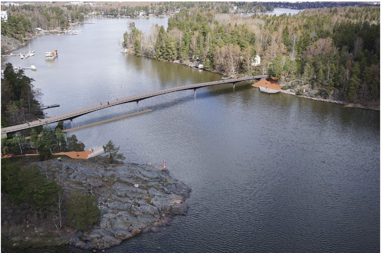
Kuva 35. Betoninen palkkisilta ylhäältä päin kuvattuna.
