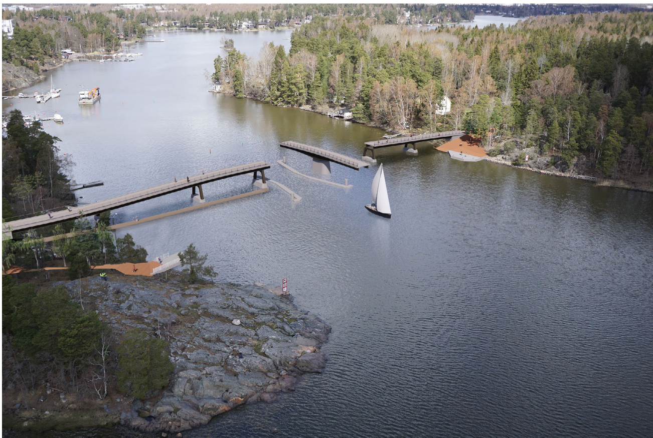
Kuva 47. Teräksinen kääntösilta ylhäältä päin kuvattuna.
