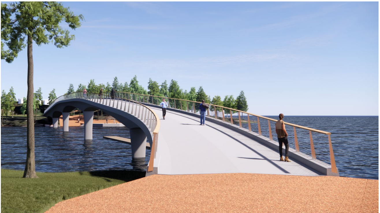
Kuva 37. Betoninen palkkisilta Laajasalon puolelta kuvattuna.
