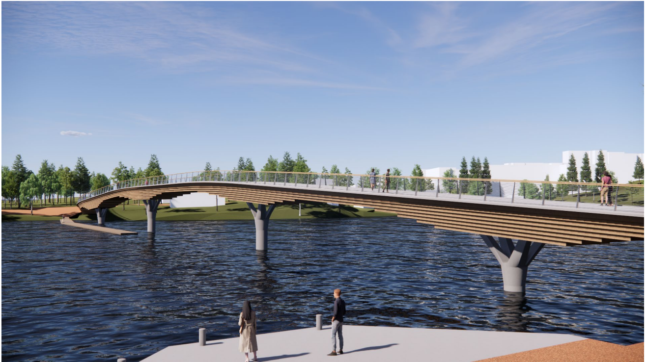
Kuva 40. Liimapuinen laattasilta Vartiosaaren puolelta kuvattuna.
