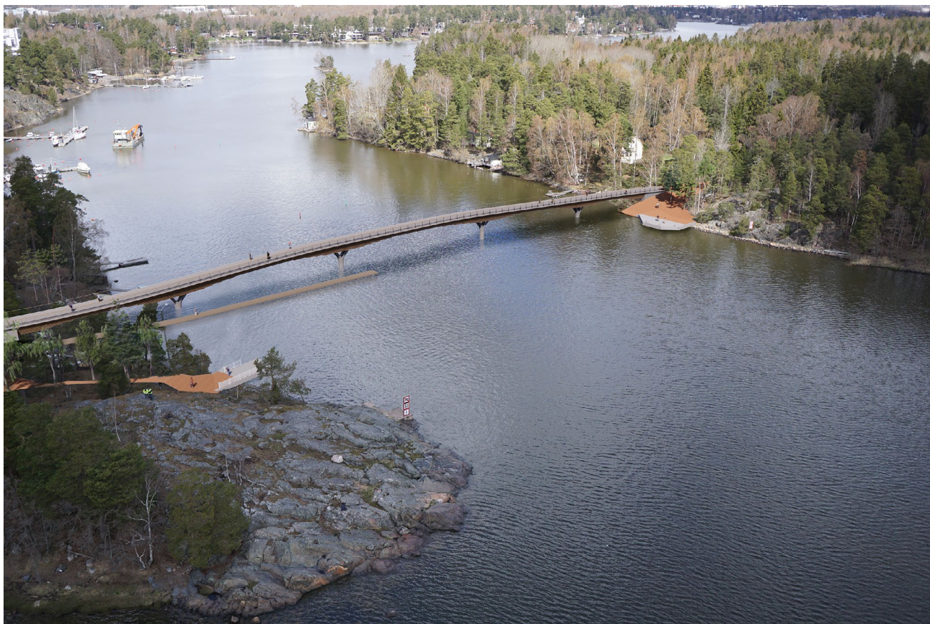
Kuva 39. Liimapuinen laattasilta ylhäältä päin kuvattuna.
