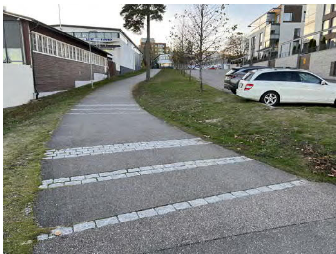
Kuva 107. Vattuniemen puistotiellä Lauttasaarella käytetään kiveysraitoja pyöräilyn ohjaamiseksi ja hidastamiseksi alamäessä. Samaa ratkaisua esitetään Isoisänsillan aukion kohdalle.
