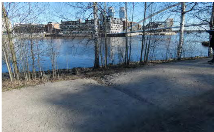
Kuva 98. Kuva rantareitiltä saaren länsirannalta. Pintavesi on kuluttanut railon reitin poikki.
