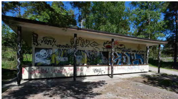
Kuva 106. Lippakioskille menee tällä hetkellä ainostaan kesävesijohdot.
