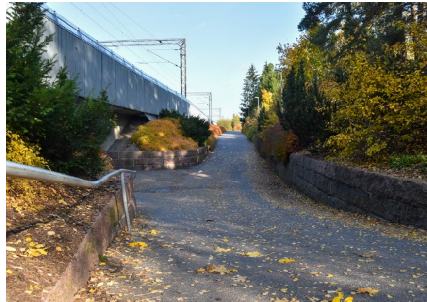
Kuva yllä: Aseman alikulun sisäänkäynti Kiitäjänpolulla.
