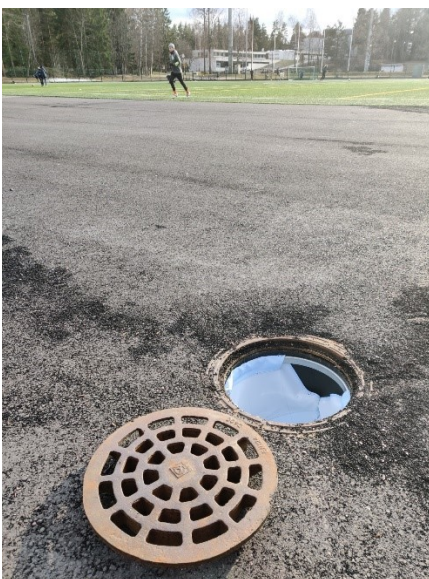
Kuva 1: Filtro -hulevesisuodattimen prototyyppi asennettuna ja mallit eri kaivokokoihin. Wateco Oy
