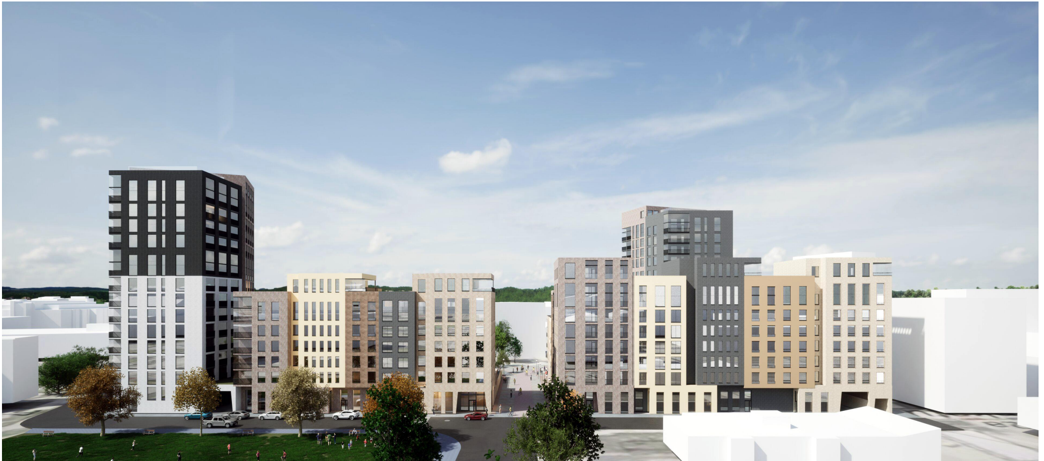
Aluejulkisivu lännestä katsottuna.
