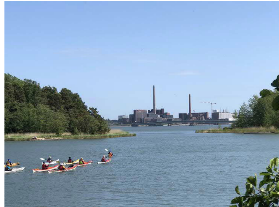
14 Lauttasaaren ja Kaskisaaren väliseltä sillalta avautuu näkymä Salmisaareen. Kuva havainnollistaa hyvin sitä, kuinka etualan toimistorakennuksista huolimatta Salmisaaren piiput ovat hallitsevia maisemassa. Uusien rakennusten massoittelu ja materiaalien avulla on onnistuttu säilyttämään maiseman merkittävät ominaispiirteet.
