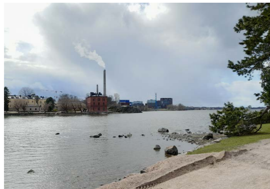
10 Ajallista kerrostumaa Lapinlahden rannoilla. Edessä Lapinlahden puiston rakennuksia ja taustalla Salmisaaren teollisuusalueen piiput sekä uudet toimistotalot. Kuvassa hahmottuu myös sähkölinjan erikoispylväiden merkitys maamerkinä.
