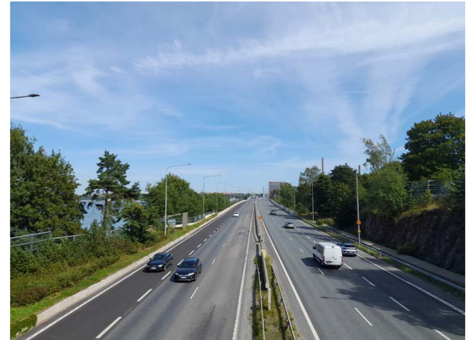
16 Länsiväylä on läntinen sisäänvaloväylä Helsinkiin. Salmisaaren mahdollinen täydennysrakentaminen tulisi vaikuttamaan sisäänvalomaisemaan.
