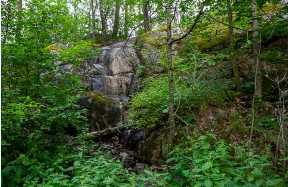
Kuva 41. Kovalla sateella vesi kerääntyy avoimelle jyrkänlehteelle kuohuvaksi vesiputoukseksi Pihlajiston läntisen selänmetsän eteläpäässä.
