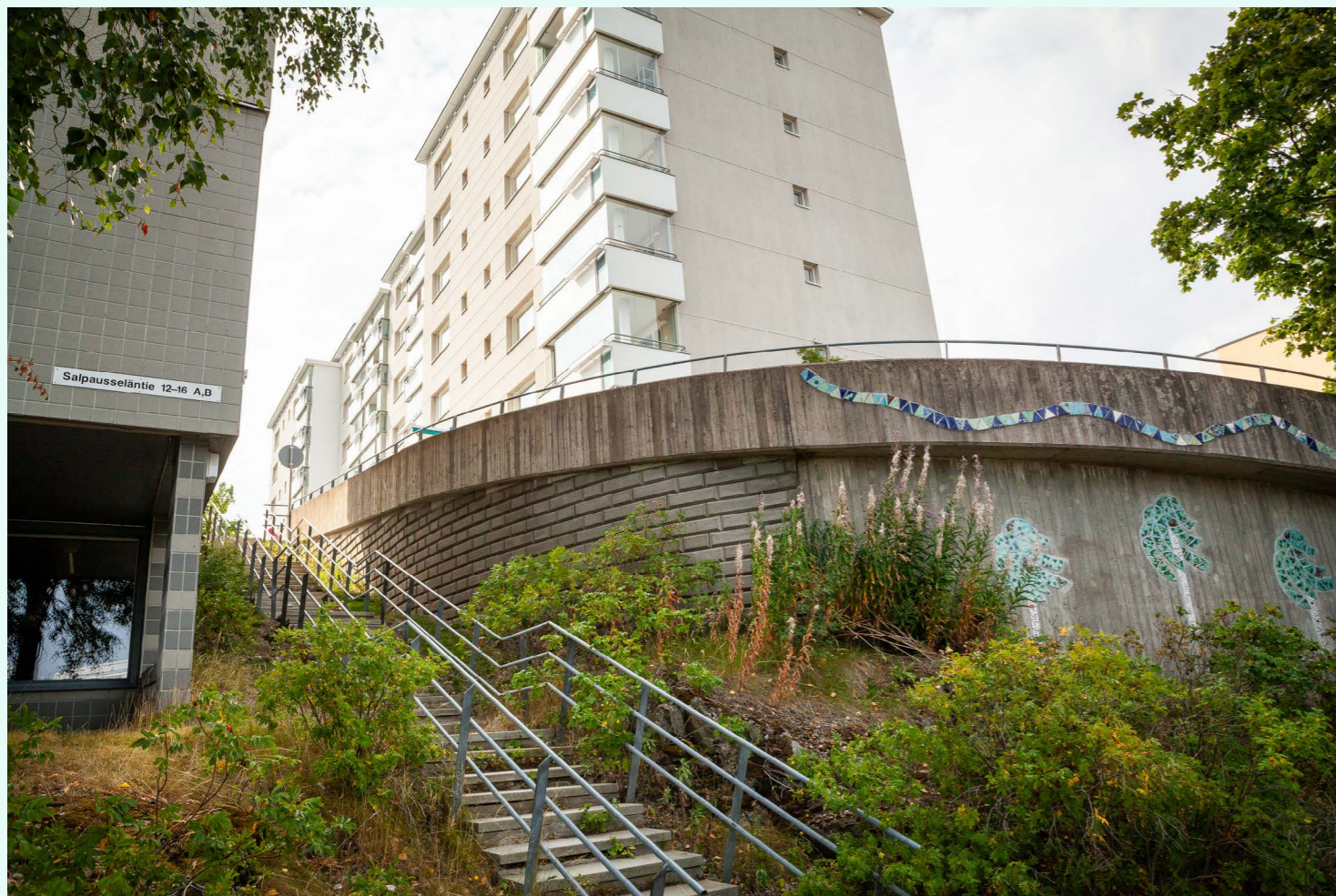
Kuva 17. Pihlajistossa aluerakentamiselle ominaista kaksitasoisuutta on toteutettu kokonaisvaltaisesti. Alikulkutunneleiden avulla suurimasta osasta asuntoja oli risteyksetön jalankulkuyhteys kouluihin, myymälöihin, puistoihin ja bussipysäkeille.
