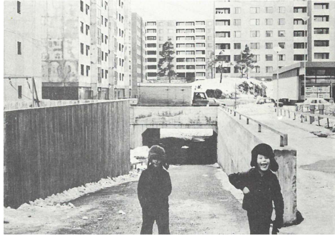
Kuva 44. Tiirismaanpolku vuonna 1974. Oikealla Pihlajiston ostari, keskellä tunnelin päässä "monttu". Kuva: Helsingin kaupunkisuunnitteluvirasto (1974). Seurantatutkimus Pihlajistosta.
