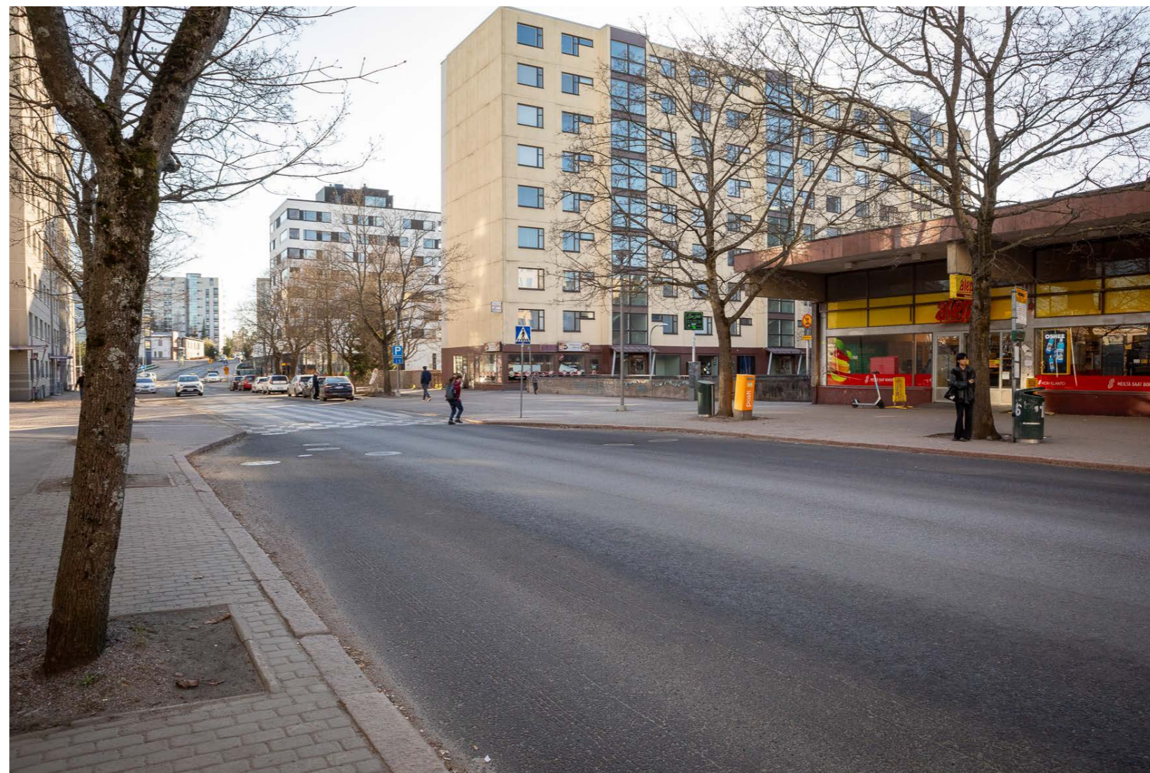
Kuva 23. Näkymä Salpausseläntieltä. Kahden päivittäistavarakaupan välissä sijaitsevan kerrostalon alin kerron on kokonaisuudessaan liiketilaa.
