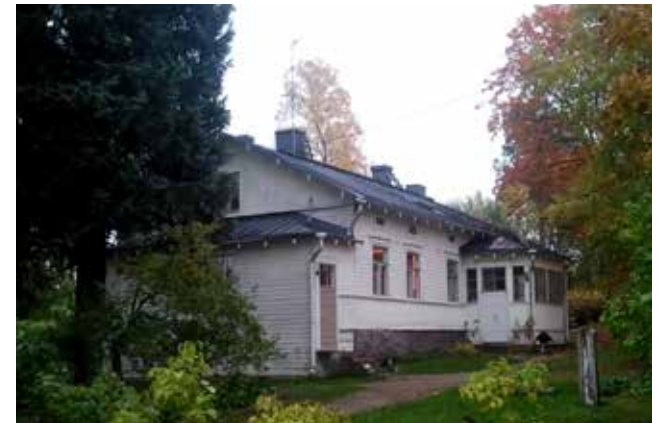
kuva 16: Kaksi rakennuksen kolmesta sisäänkäynnistä vuonna 2013. Ulko -ovet on uusittu ja edessä puun taakse jäävään kuistiosaan on lisätty ikkunoita. Muuten tässä julkisivussa ei ole tapahtunut merkittäviä muutoksia.
