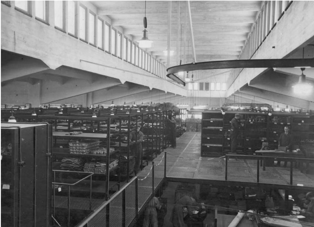
2. kerros, kattolyhty varaosavarastona.FORD, MOBA
