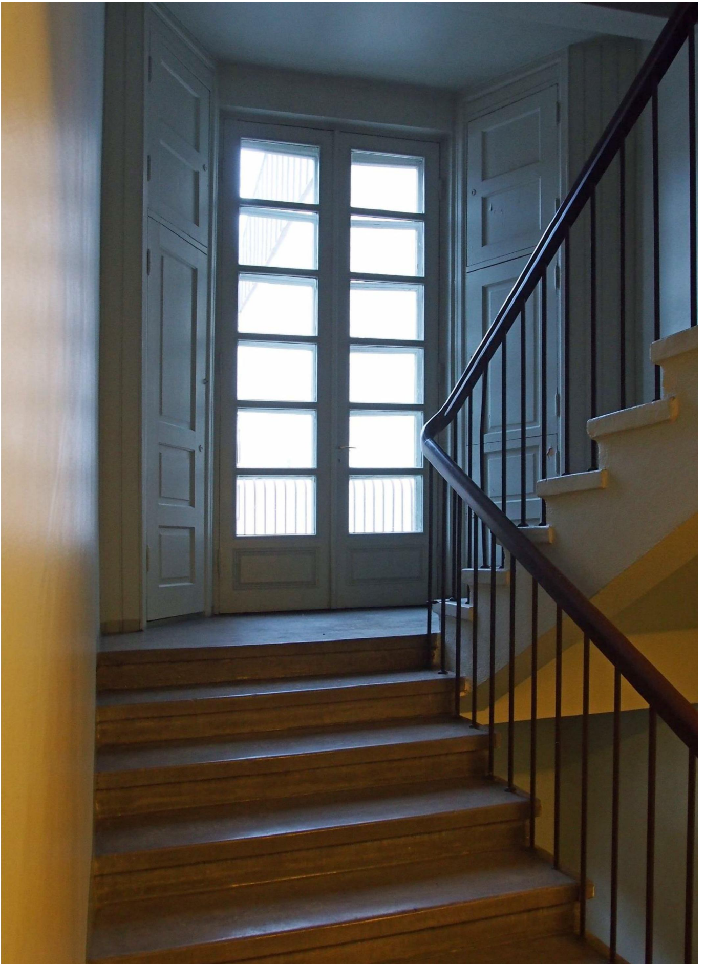
Porrashuoneen tuuletusparvekkeen ovet ja sivukomerot. Kuva: Sakari Mentu
