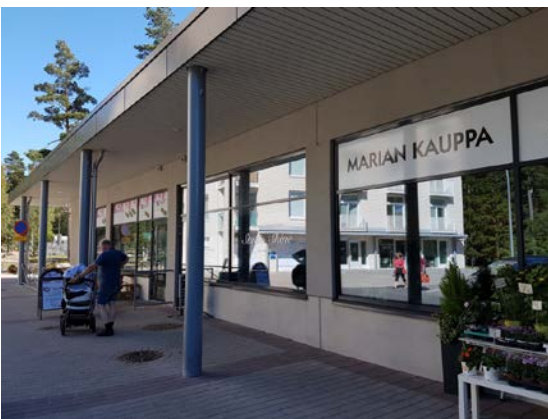
Vuosaaren pohjoisen ostoskeskuksen laajennus rv. 2016
