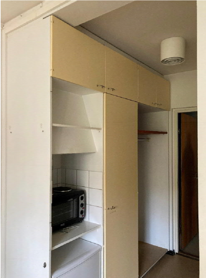
Kuva 14. Medioma I, alkuperäinen eteiskaluste ja minikeittiö. Keittotilassa alun perin olleen keittolevyn tilalle on asennettu myöhemmin mikro. Alinna pienoiskokoinen jääkaappi.
