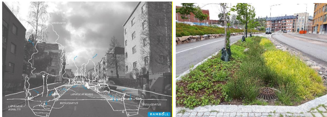
Kuva 8 Hulevesien hallintaa kadun varressa (kuvat Ramboll)
