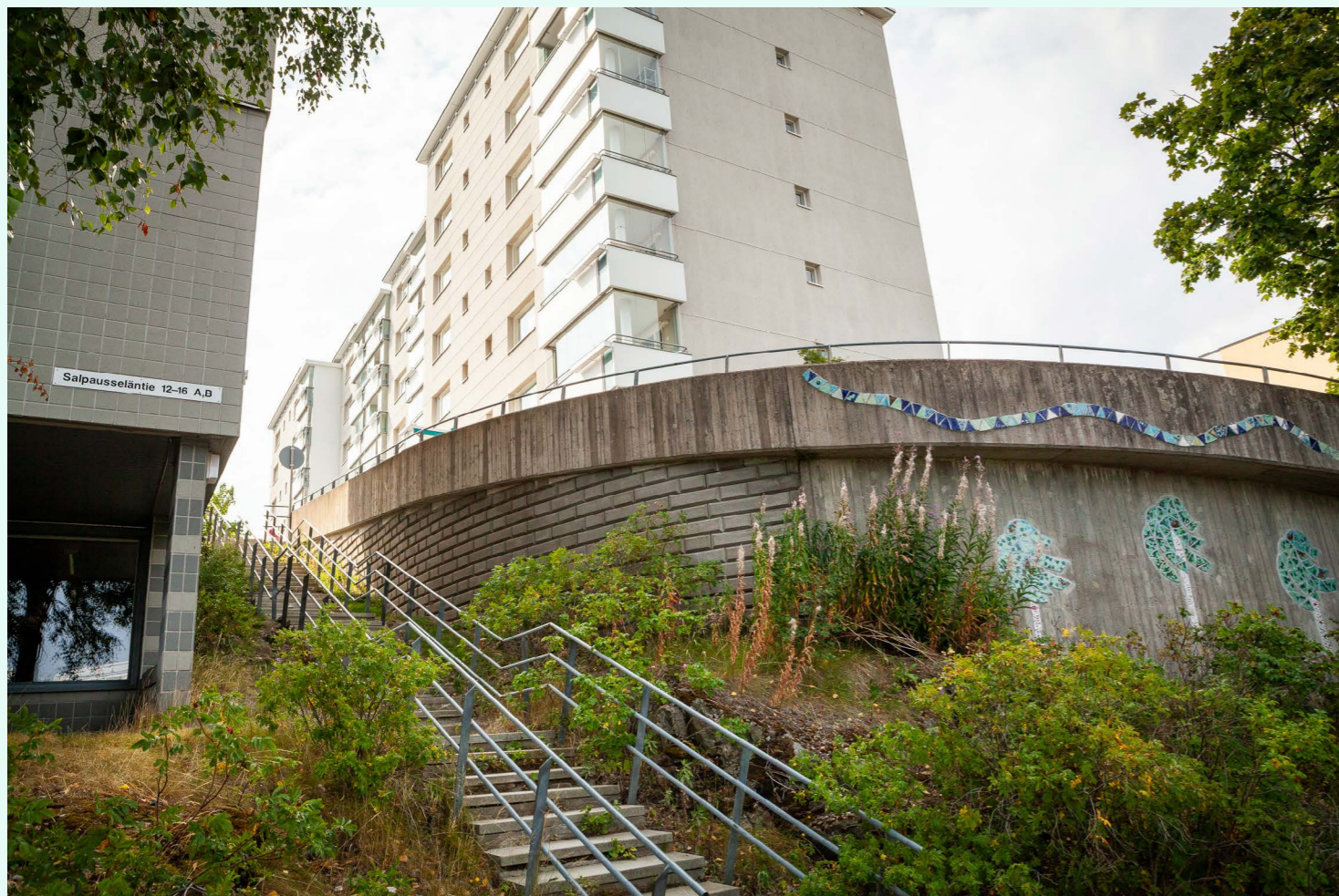
Kuva 17. Pihlajistossa aluerakentamiselle ominaista kaksitasoisuutta on toteutettu kokonaisvaltaisesti. Alikulkutunneleiden avulla suurimasta osasta asuntoja oli risteyksetön jalankulkuyhteys kouluihin, myymälöihin, puistoihin ja bussipysäkeille.
