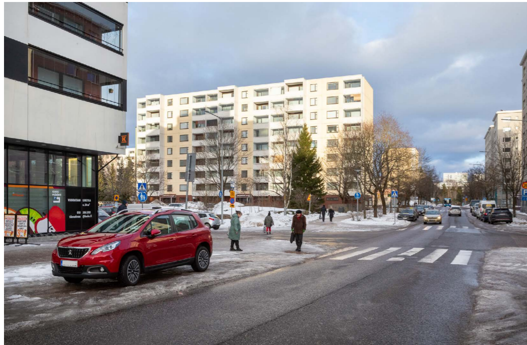
Kuva 83. Salpausseläntie nyt. Oikealla kuvan ulkopuolella portaat alas pikaraitiotien pysäkillä, vasemmalla uusi K-kauppa. Edessä rakentamaton lähipalvelurakennusten tontti, ja taustalla Pihlajiston ostari.
