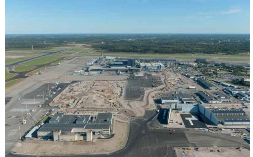
Kuva 25. Uuden koekäyttöpaikan ilmakuva lounaan suunnasta katsottuna. Koekäyttöpaikan kolme seinäkettä sijaitsevat kuvan oikeassa alareunassa.
