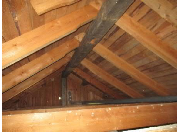
Ruodelaudoissa ei havaittu kosteusjälkiä
