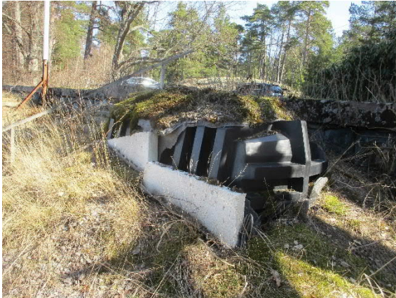
Pihalla havaittiin viemäröintiin liittyvänä ainoastaan tämä yksi jätevesisäiliö, lienee umpisäiliö. Asennukset on syytä tarkastaa
