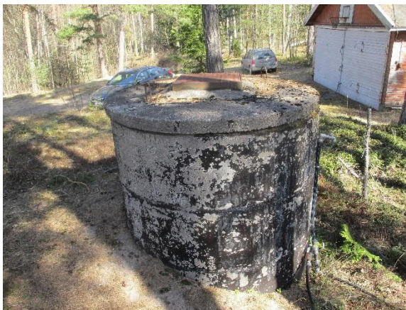
Kiinteistön pihalla sijaitseva vesikaivo on porakaivo, betonirenkaiden sisällä painesäiliö
