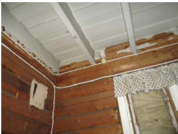
Paikoin pintaverhoilut poistettu ja hirsipinta näkyvillä
