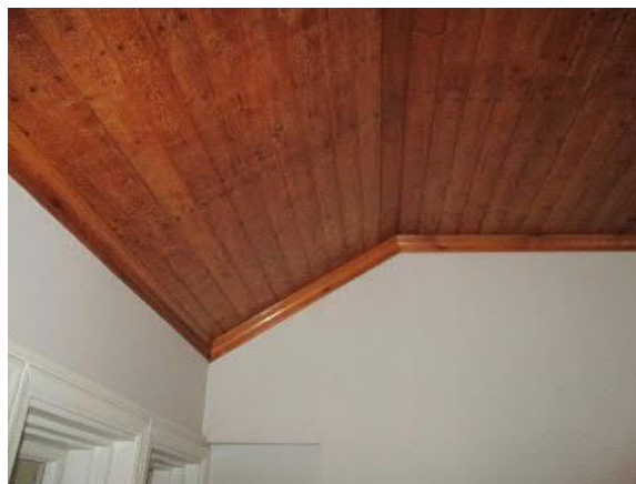
Yleiskuva sisätiloista, paneloitu katto
