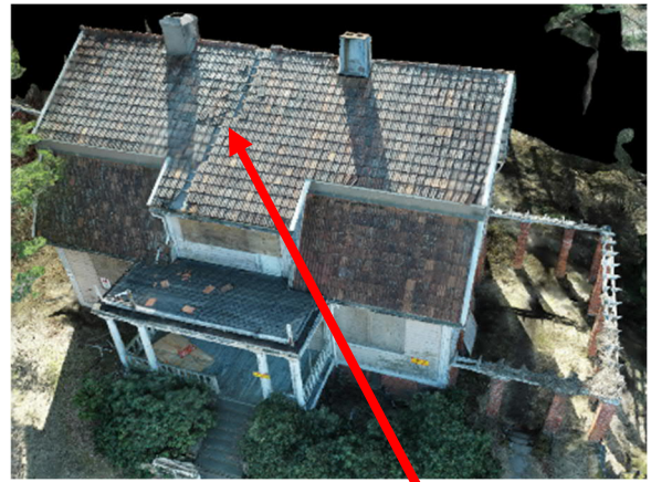
Yleiskuva pohjoisen puolen lappeista (Dronen pistepilvikuva), pudonnut tiilirivi
