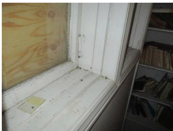
Ikkunoiden sisäpuite puoistettu
