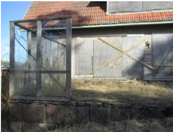
Takapihan terassi maapohjalla
