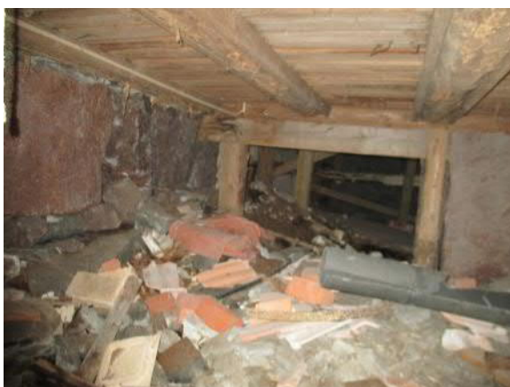
Ryömintätilassa rakennusjätettä
