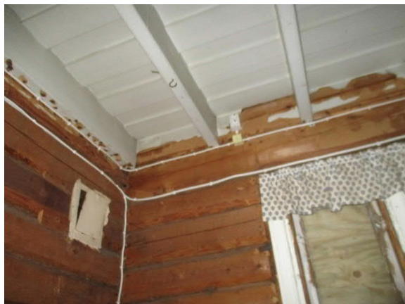
Luukkumallinen korvausilmaventtiili
