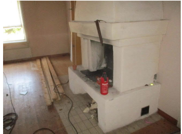
Päärakennuksessa oleva takka
