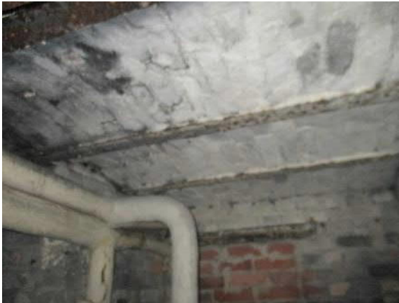
Osittain alapohjarakenteena kappaholvi
