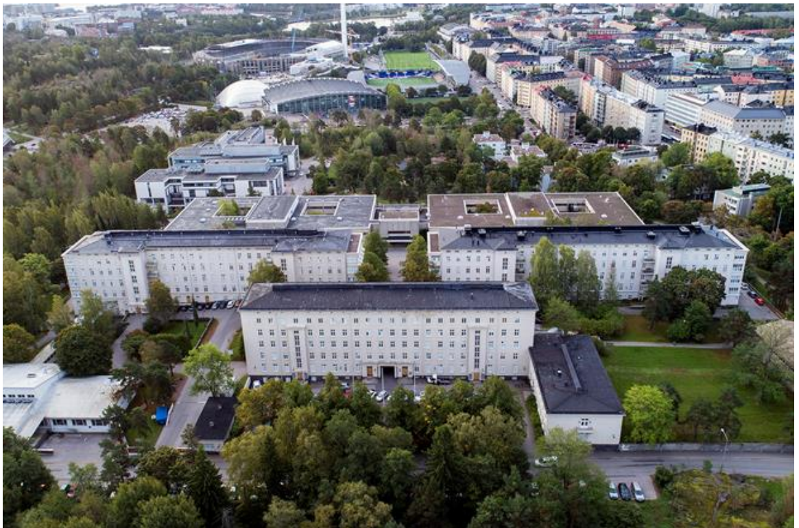
Laakson sairaala-alue ennen hankkeen käynnistymistä katsottuna pohjoisesta etelään päin. Etualalla asemakaavassa suojeltu vanha sairaala-alue. Hankkeesta pois jäävä viisikerroksinen rakennus 1 (LG) ja sen kahden
