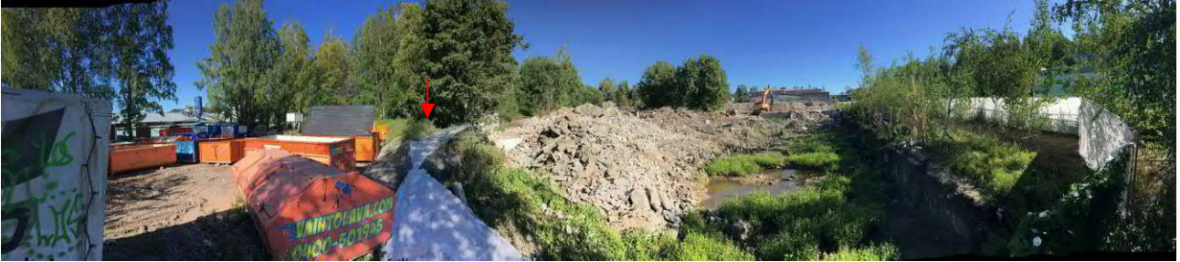
Näkymä mittauspisteen 1 vierestä tarkastelualueen keskiosaa kohti. Mittauspiste 2 sijoittui kuormalavojen takana olevan maavallin ja purku-urakkaa rajanneen työmaa-aidan väliin.
