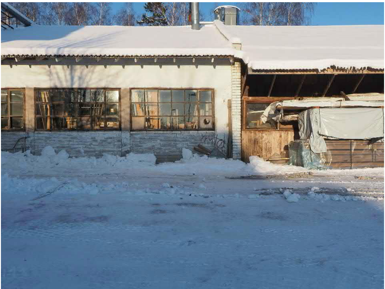
Höyläämön ja puutavarakatoksen yksityiskohtia
