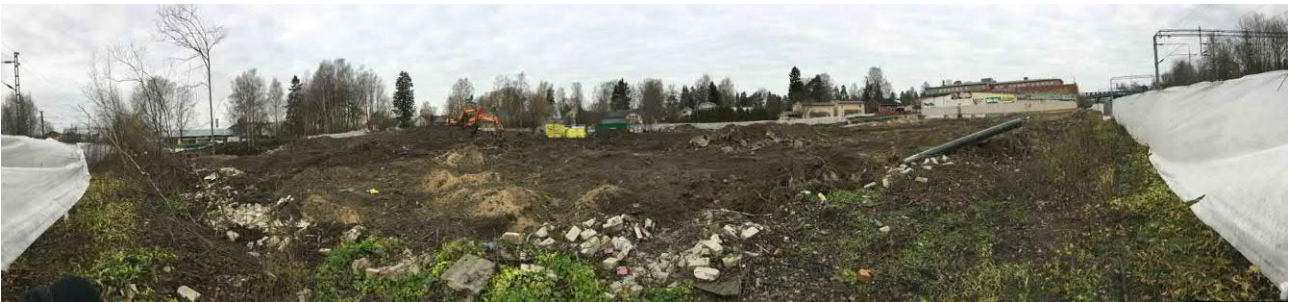
Panoramakuva purkutyömaa-alueen eteläpäädyistä pohjoiseen.
