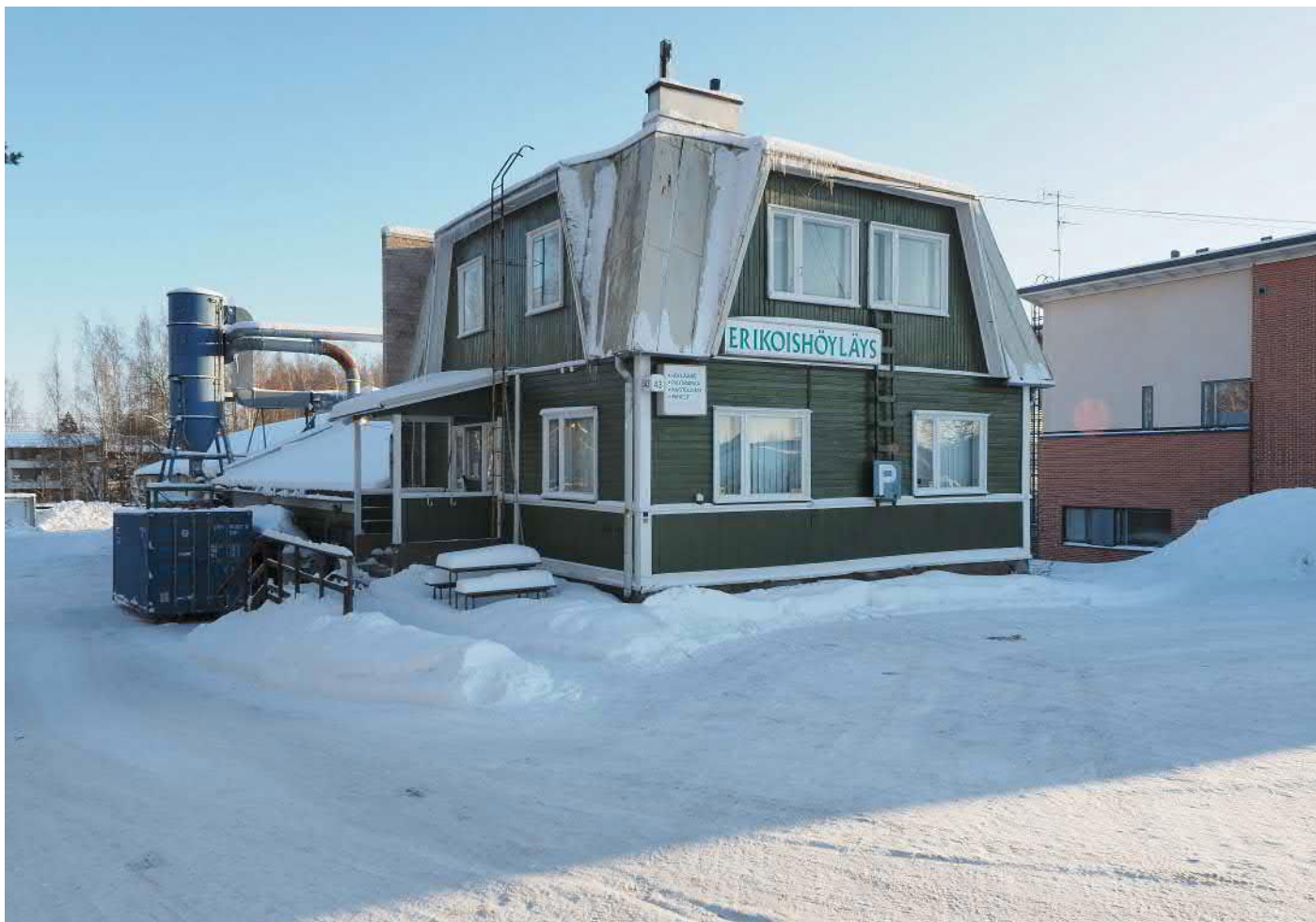
Rakennus kuvattuna pohjoisesta
