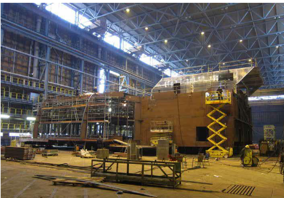
Laivalohkon työ Suurlokkohallissa 2011
