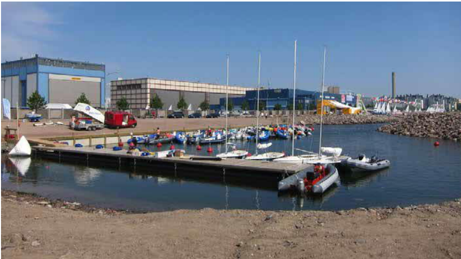
Hernesaaren väliaikainen vesibussilaituri 2011
