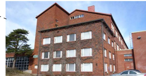
Säilytettävä tehdasmiljöön tiilirakennus muodostaa Insinöörinkadun pihakadun aukiolle mielenkiintoisen selustan. Rakennuksen kyykeen myöhemmin rakennettu tehdashalli puretaan.
