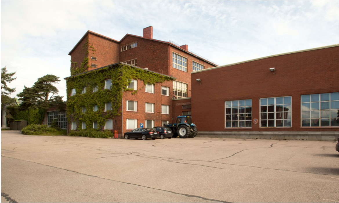
Tehdasrakennuksen eteläjulkisivussa yhdistyy monia eri rakennusvaiheita
