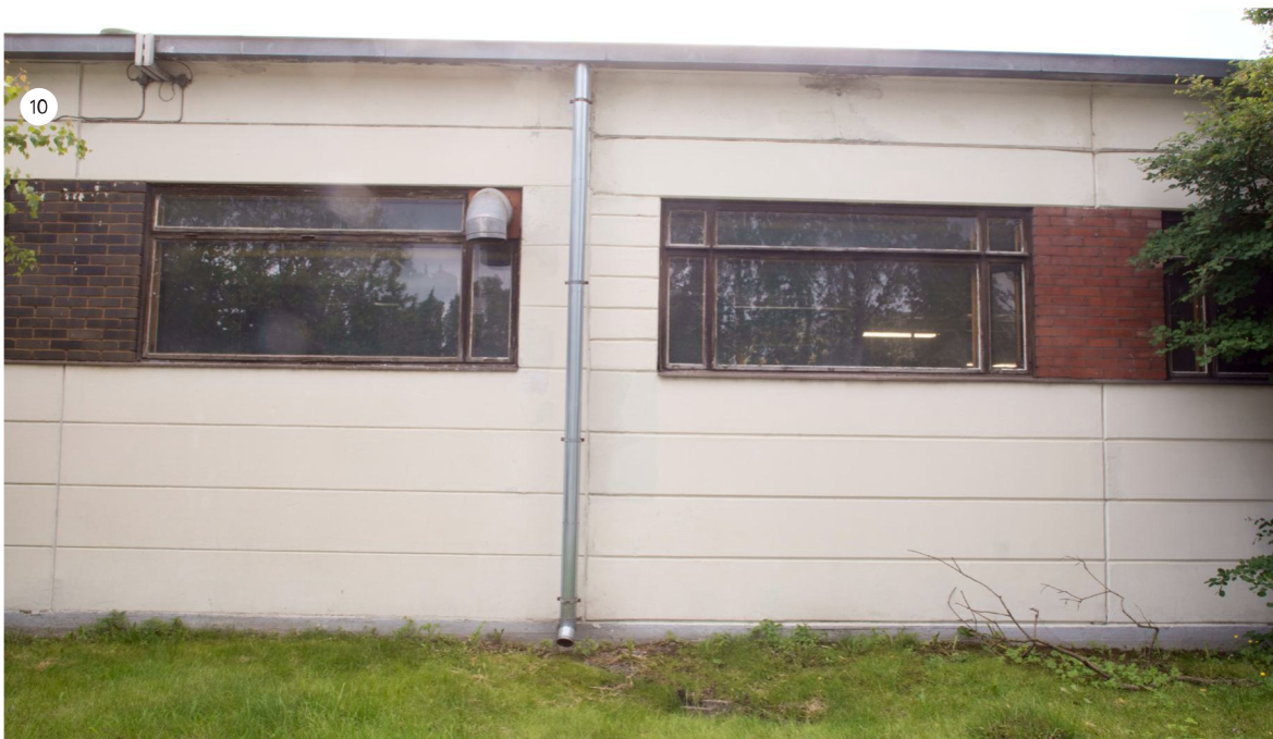
Vuosien 1963 (1c) ja 1966 (1 d) laajennusten liitoskohta. Materiaalit ja massoittelu pysyvät samoina, mutta tiilidetallit on muurattu tummemmasta tiilestä.
