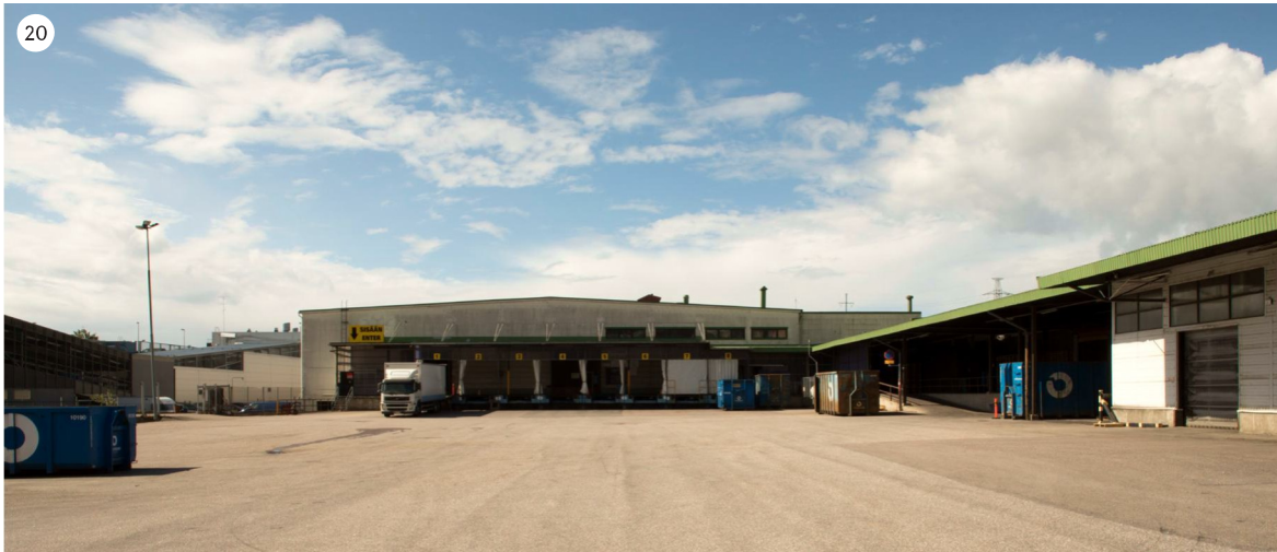
Varastorakennus rajaa lastauspihaa. Rakennus on suuri neliömäinen massa, jossa on erittäin loiva harjakatto. Julkisivun edessä on katettu lastausramppi.
