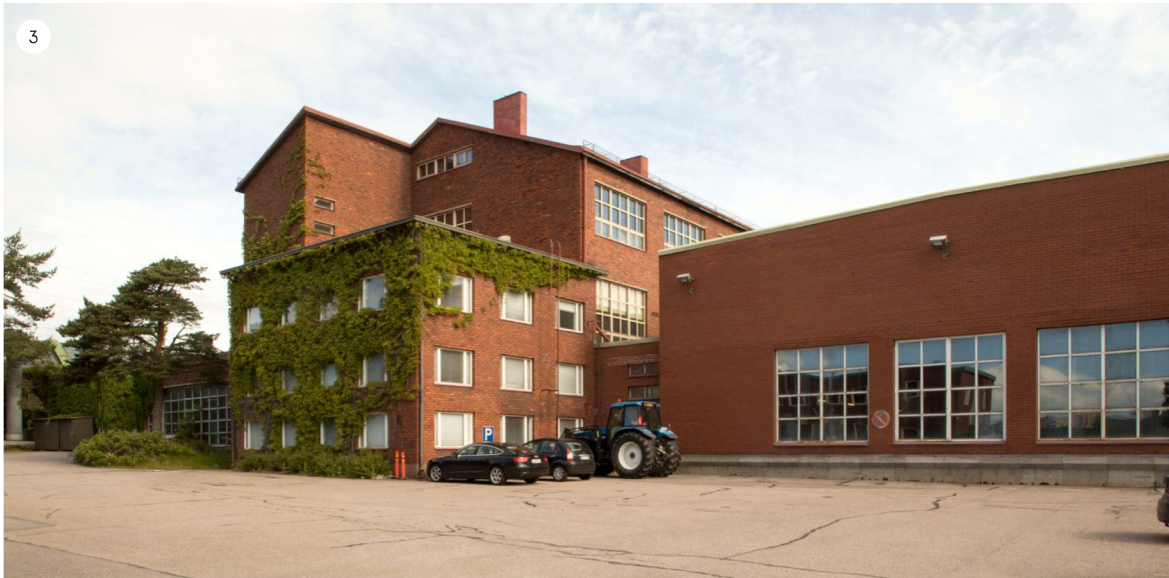
Taka-alalla näkyy alkuperäinen tehdasrakennus. Kuutiomainen rakennusosa on vuonna 1954 rakennettu laajennusosa jonka suunnitteli arkkitehti Ragnar Gustafsson. Vasemmalla on vuonna 1967 valmistunut laajennusosa ja oikealla on vuonna 1984 valmistunut, viimeinen laajennus.
