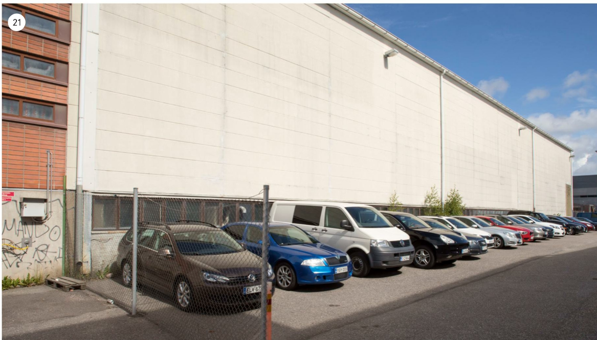
Varaston itäjulkisivu on laaja ja umpinainen. Ikkunoita on ainoastaan sokkelilinjan yläpuolella.
