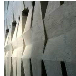
Osa muureista voidaan toteuttaa betonirakenteisina. Suurille muuripinnoille muodostetaan vaihtelua murtamalla suuret pinnat pienemmiksi sekä terassoituvilla istutustasolla. Tavoite on välttää suurta, homogeenista muuripintaa.
