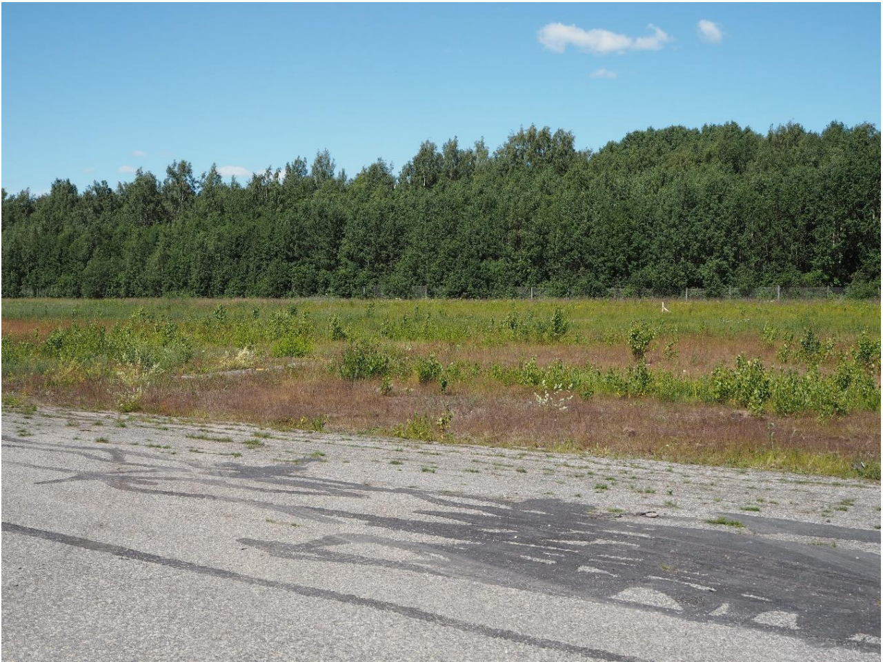
Kuva 3. Lehtipuiden ja pensaiden taimia oli havaittavissa itäisen kiitotien pohjoisella reunalla ennen v. 2019 tehtyä niittoa (kuvauspäivä 28.6.2019, kuva Laura Turunen).
