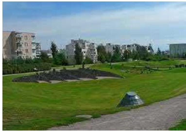
paikallisia hulevesiä keräävä, imeyttävä ja viyyttävä nurmipainanne on viittaus Mustankivenpuiston avoimesta maisemasta
