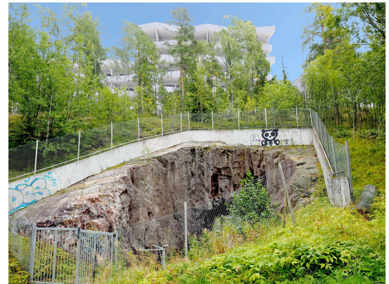
2. Huoltotunnelin sisäänkäynnin kohdalta
