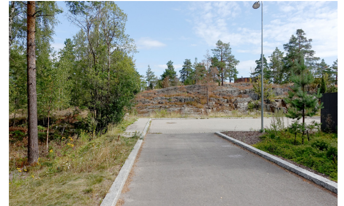
Ensi Parven katutila, näkymä kohti rakentumattomia asuintontteja
