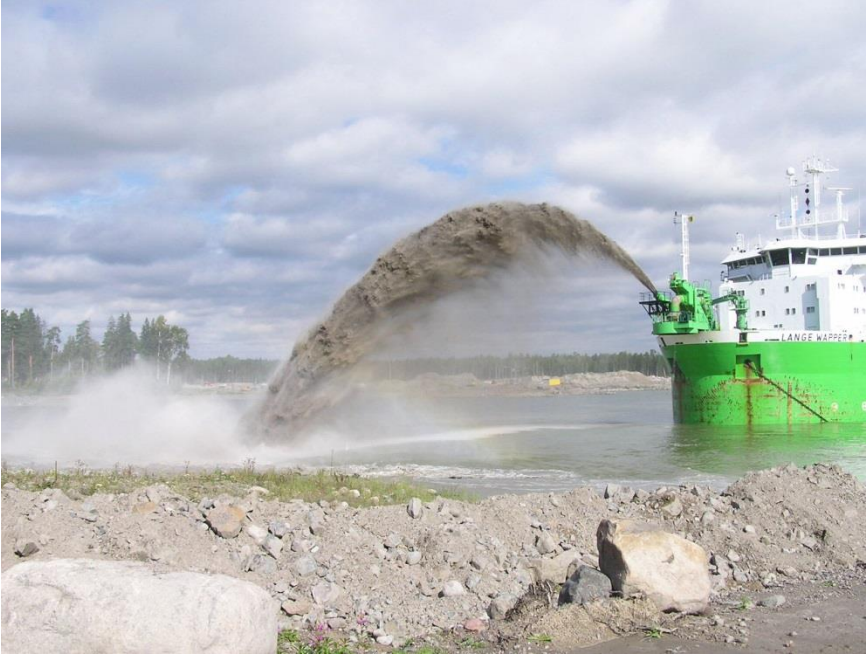
Kuva 9. Vuosaaren sataman rakentamisessa merenpohjalta nostettua kiviainesta hyödynnettiin sataman pohjan täyttöihin. Belgialainen Lande Wapper -hiekkahopperi toi merihiekkaa Vuosaaren sataman täyttöihin. Helsingin satama 2004/Paavo Lyytinen
