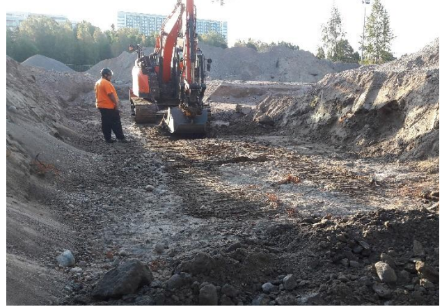
Valokuva 2. Kuopan kaivuuta anturilinjalla.
