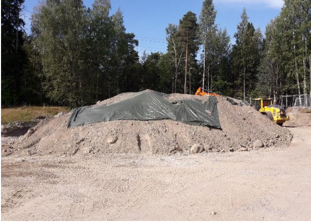
Valokuva 1. Anturilinjalta kaivetun maan kasa.
