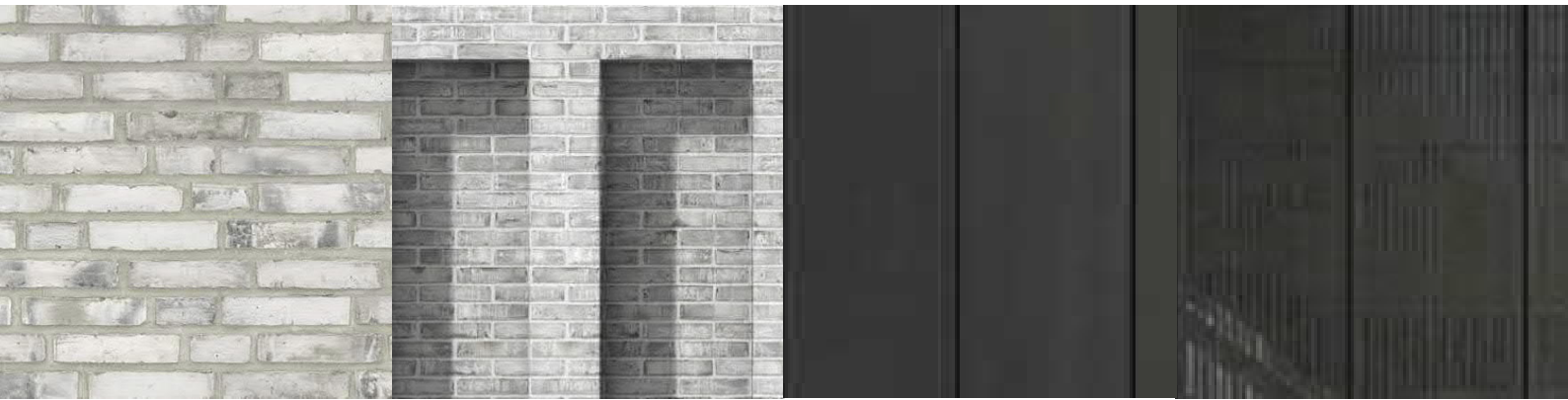
1. PAIKALLA MUURATTU TIILI Petersen Tegel Mursten D91 (228x108x40mm) Harmaa muurauslaasti
