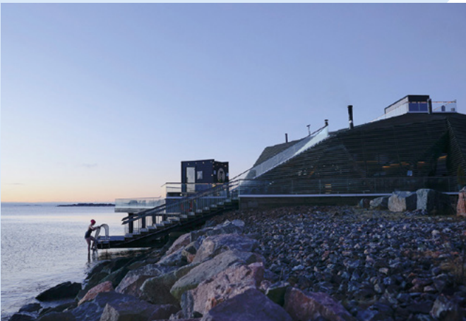
Yleinen sauna ja ravintola Löyly, Hernesaaren rannassa on Helsingin nuorin suojeltu rakennus.
