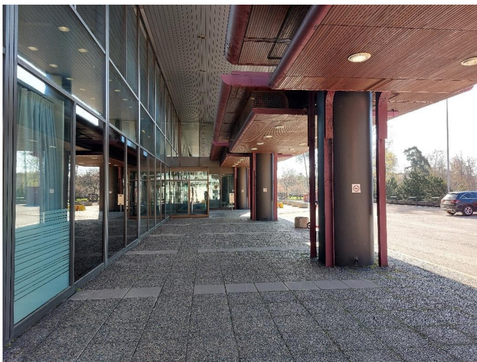
Sisäänkäyntiä korostavat komeat katokset ja suuret ikkunat.
