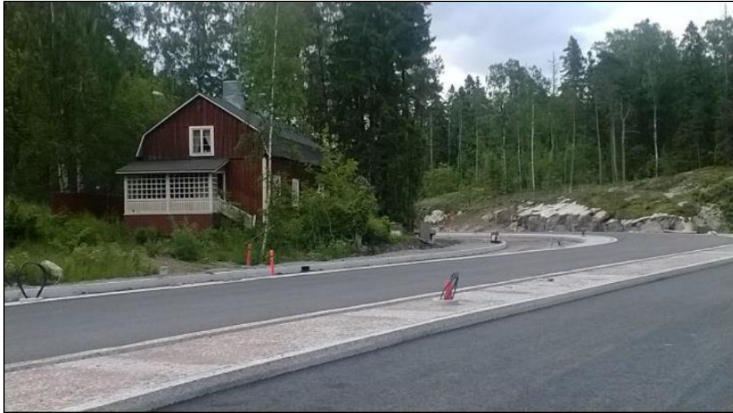
Kuva 1. Uusi Koirasaarentie Kaivoshuvilan eteläpuolella kesäkuussa 2015.
