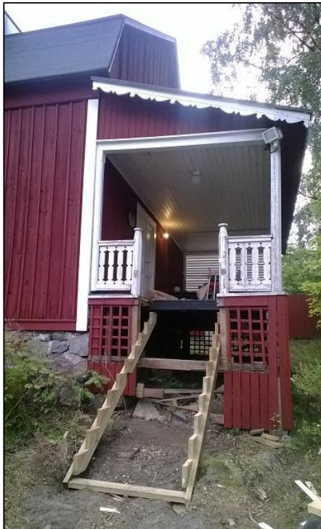
Kuva 21. Kaivoshuvilan itäisemmän verannan kaiteet ja rappu uusittiin heinä-elokuussa 2015.
