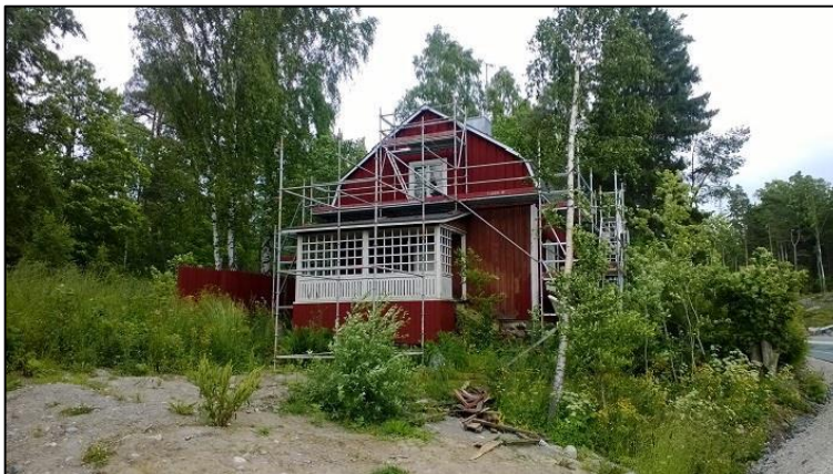
Kuva 20. Kaivoshuvilan maalaustyö on melkein valmis.
