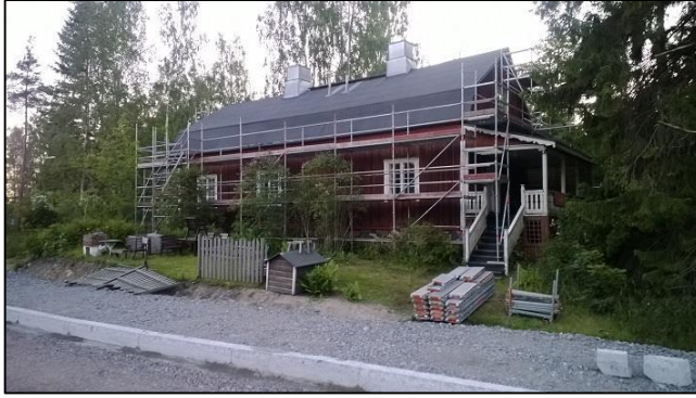
Kuva 19. Kaivoshuvilan ympärille asennettiin rakennustelineitä kesäkuun lopussa.
