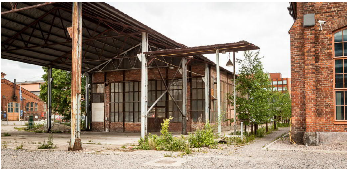
Eteläinen katos ja siihen liittyvä pienempi sivukatos, 2018.
