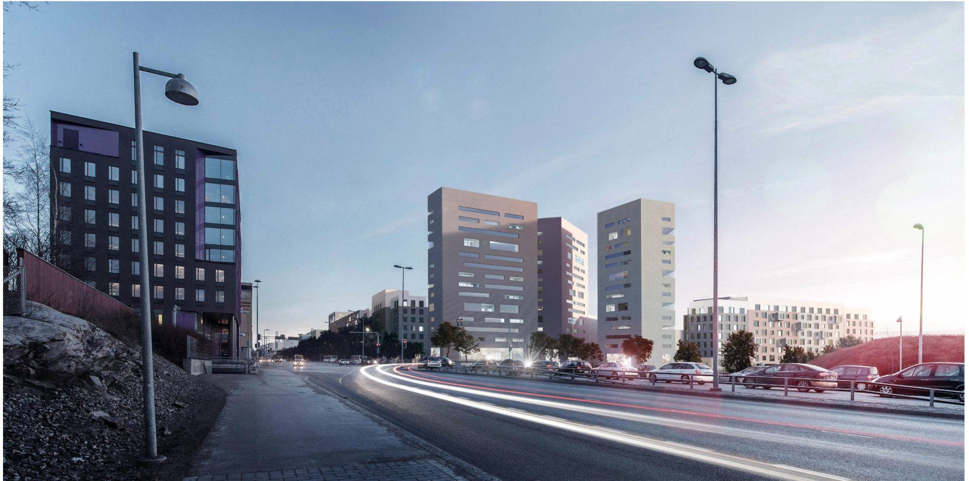
Näkymä Hämeenlinnanväylältä Kolmelle Sisarelle
