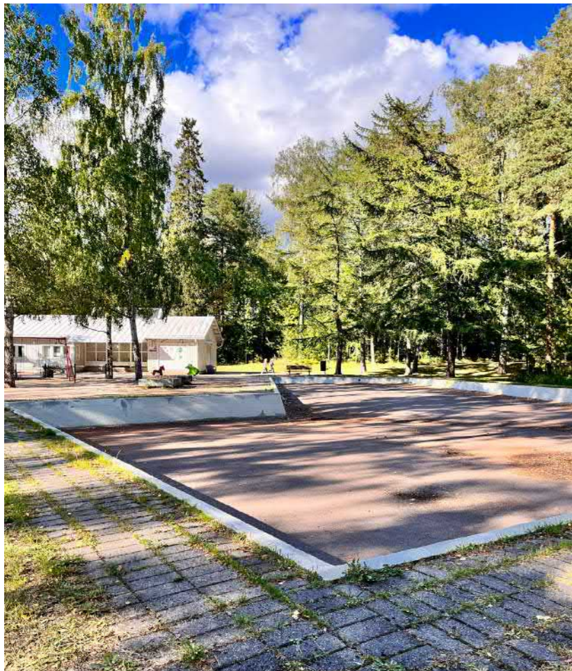
Kahluuallas vastaa muotokieleltään ja sijainniltaan lähes puiston alkuperäistä suunnitelmaa 1960-luvulta. Nykyistä allasta kehystää betonikiveys alkuperäisessä suunnitelmassa esiintyvän liuskekiveyksen sijaan. Betonireunus on säilynyt kohtuullisen hyvin.
