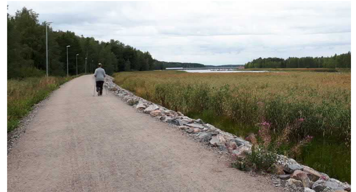
Esimerkki merivesitulvilta suojaavasta tulvavallista. (Vartiokylänlahti, kesä 2018)
