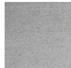
Betoni kadut, jalankulku, pysäköintialueet
