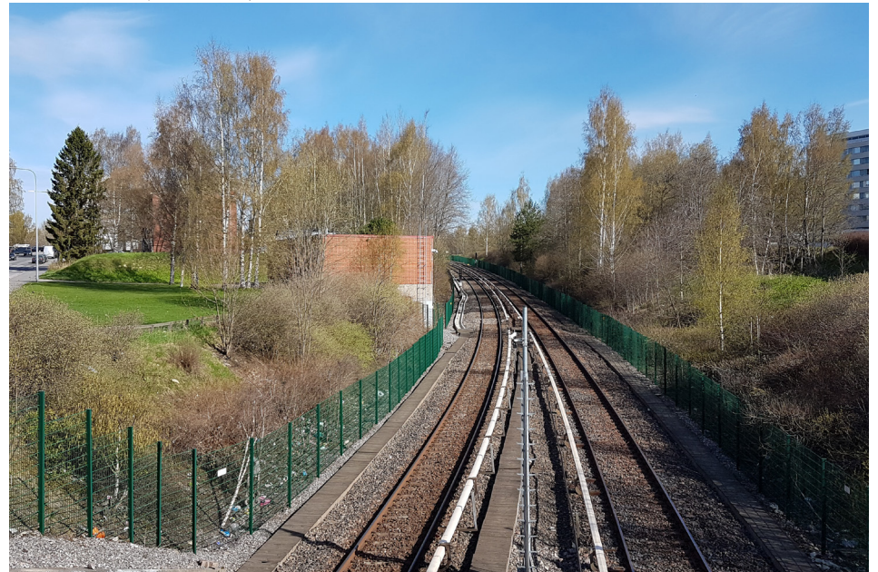
Metron sähkönsyöttöasema ja metrorata.
