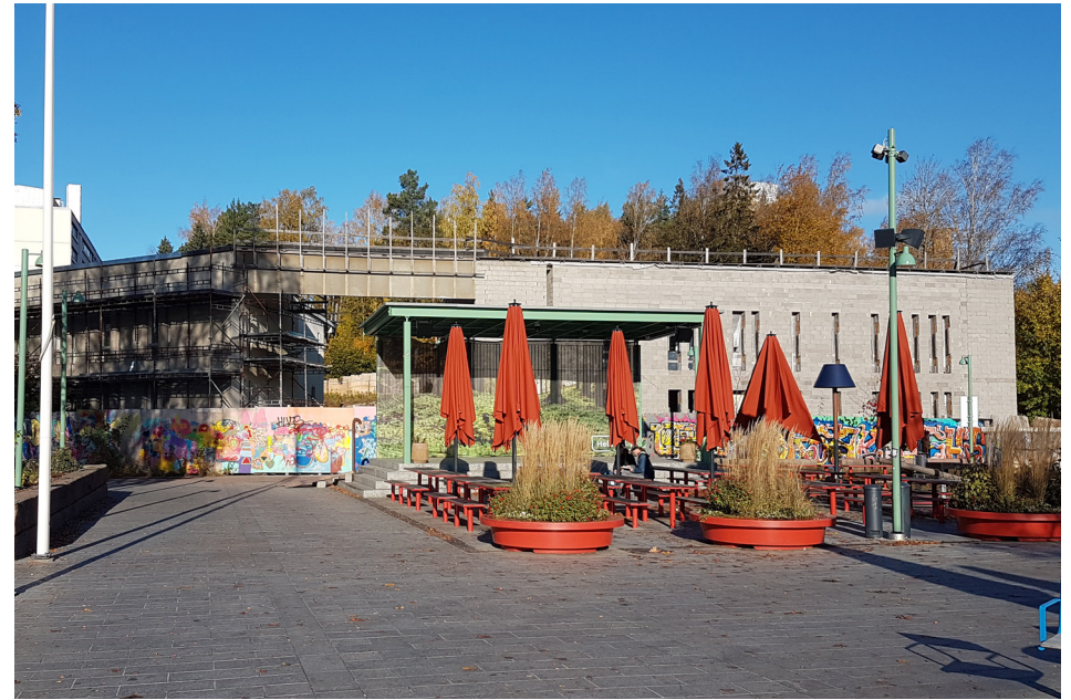
Ortodoksikirkon keskeneräisiä seurakuntarakennuksia Stoan aukion pohjoislaidalla.
