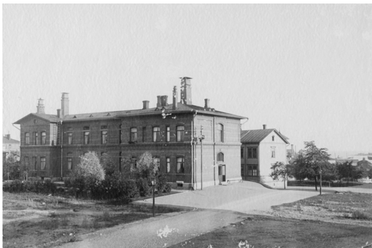
Koordinaatistot kohtaavat edelleen tiilipaviljongin ja vanhan puurakennuksen kohdalla. Alueen keskiosan mittakaava on keskikorkeiden rakennusten määrittämä. Taustalla näkyy alueen matala eteläosa. HKM.
