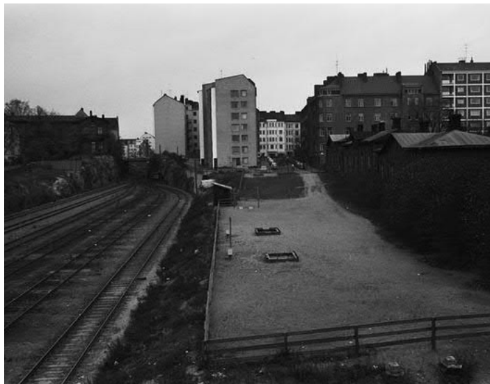
Työmiehenkatu pilkottaa Työmiehenpuistikon takana rakennusten välissä. Kuva on otettu 1970-luvulla. HKM/Eeva Rista 1970.
