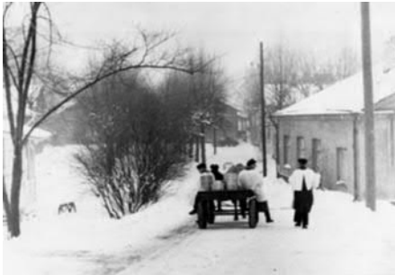
A. Rakennukset sijaitevat väljästi puistomaisessa ympäristössä. HKM.
