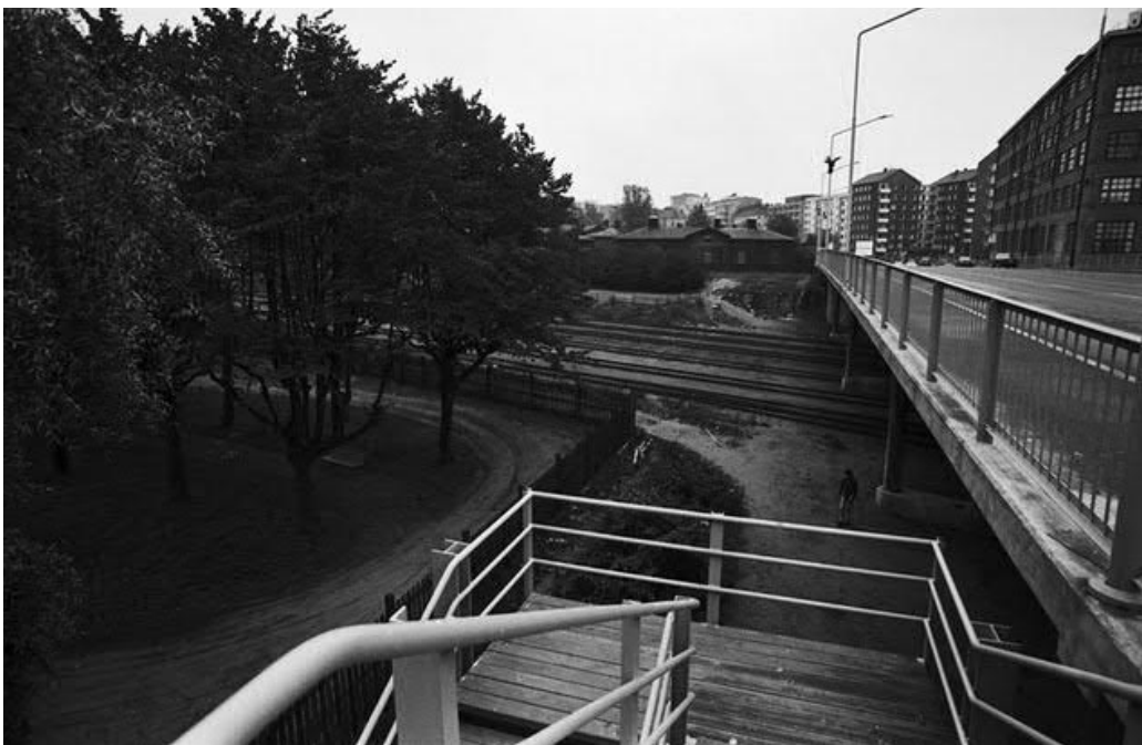
Oikealla Porkkalankadun silta, jonka Satamarata alittaa. Kuva on otettu 1970-luvulla.. HKM/Simo Rista 1970.
