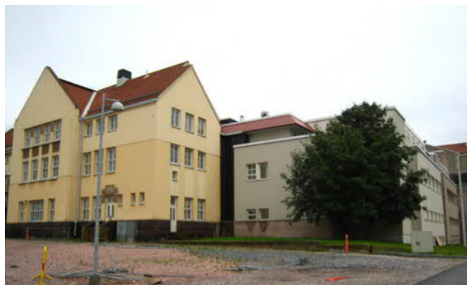
Meckelininkadun ja Lapinlahdenkadun kulmaan 1992 valmistunut uudisrakennus.
