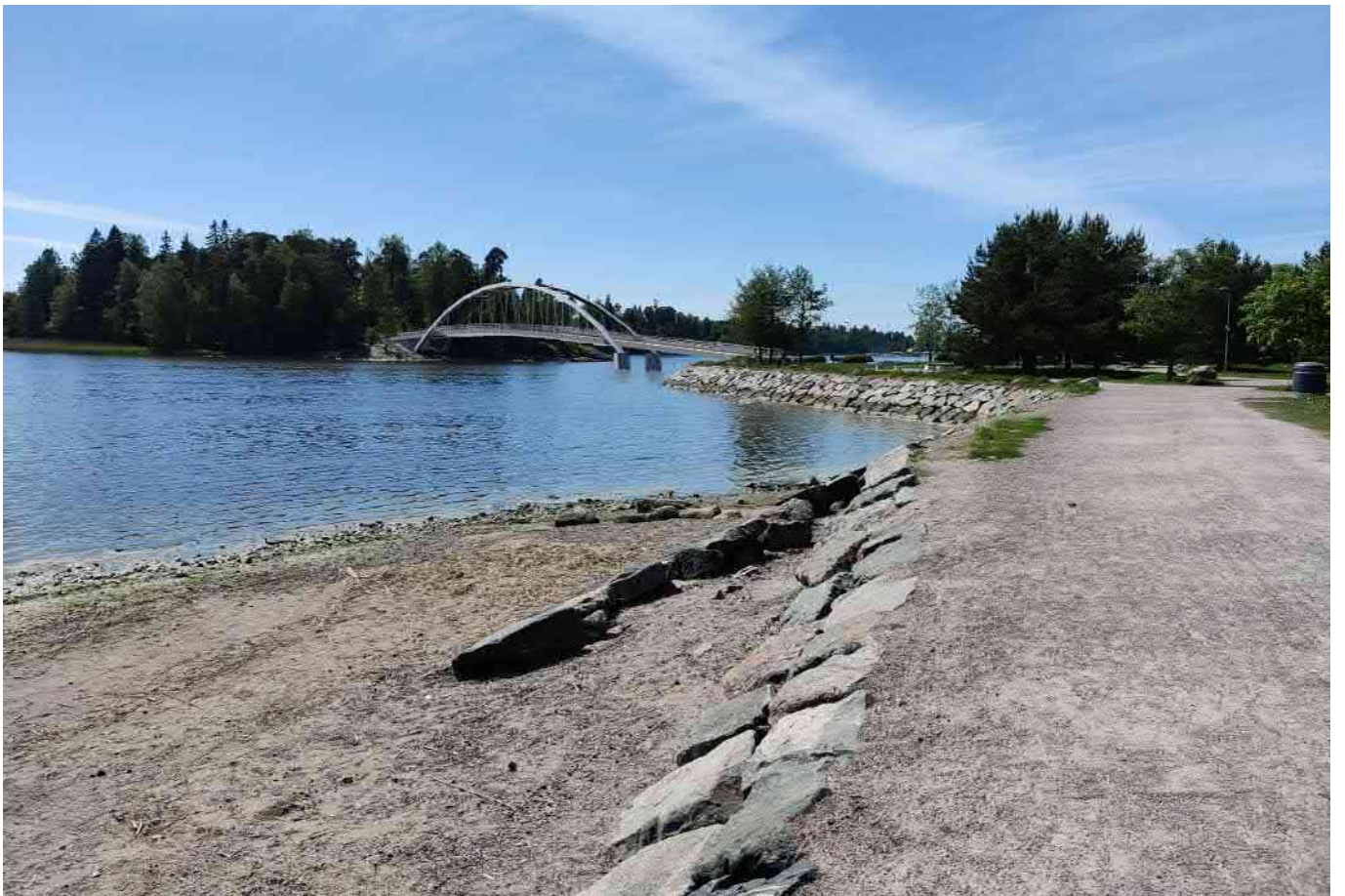
Kuva 26. Silta (VE1B) uimarannalta, idästä katsottuna.
