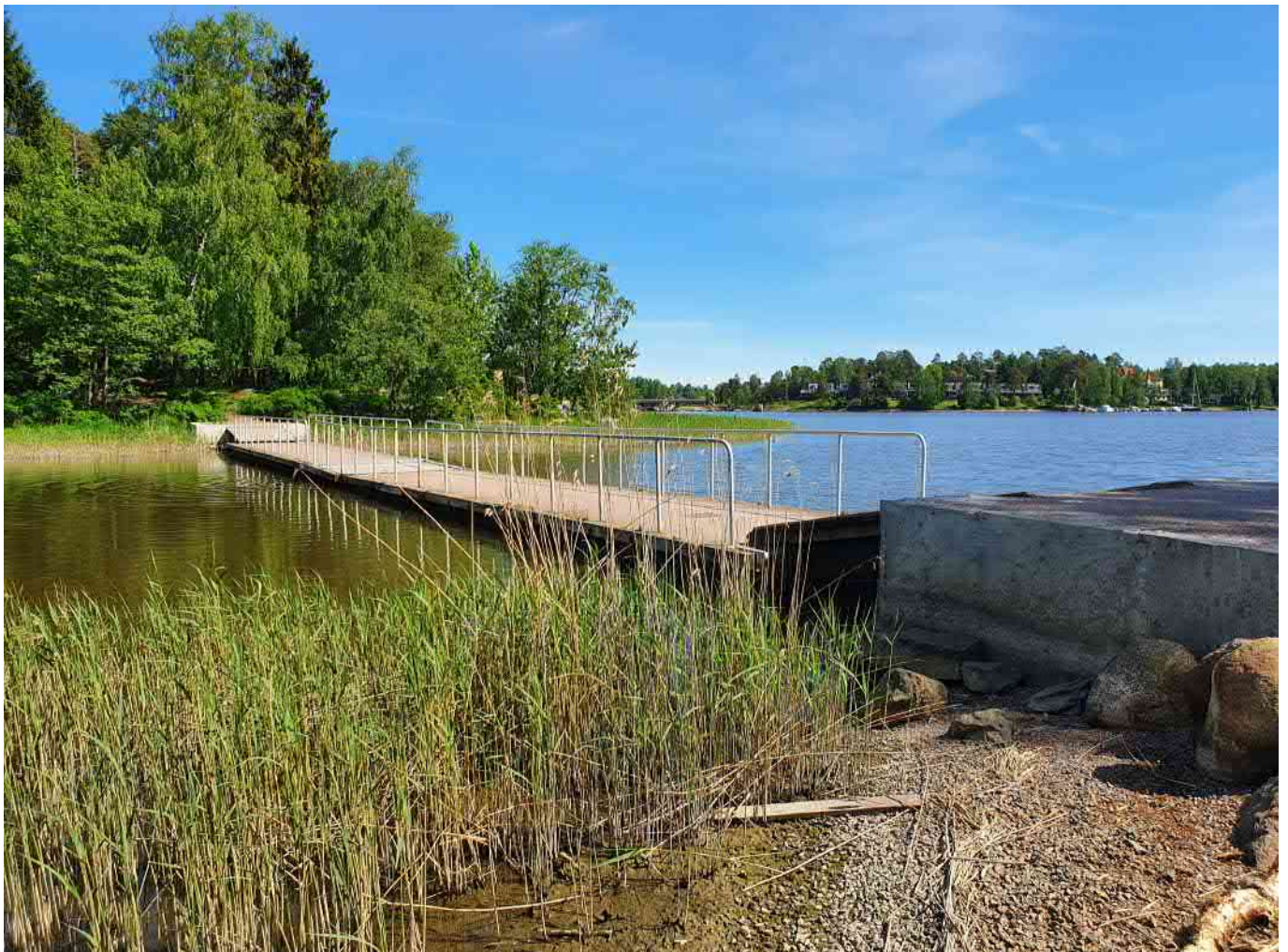
Kuva 5. Ponttonisilta Tullisaaresta Killingholmaan.
