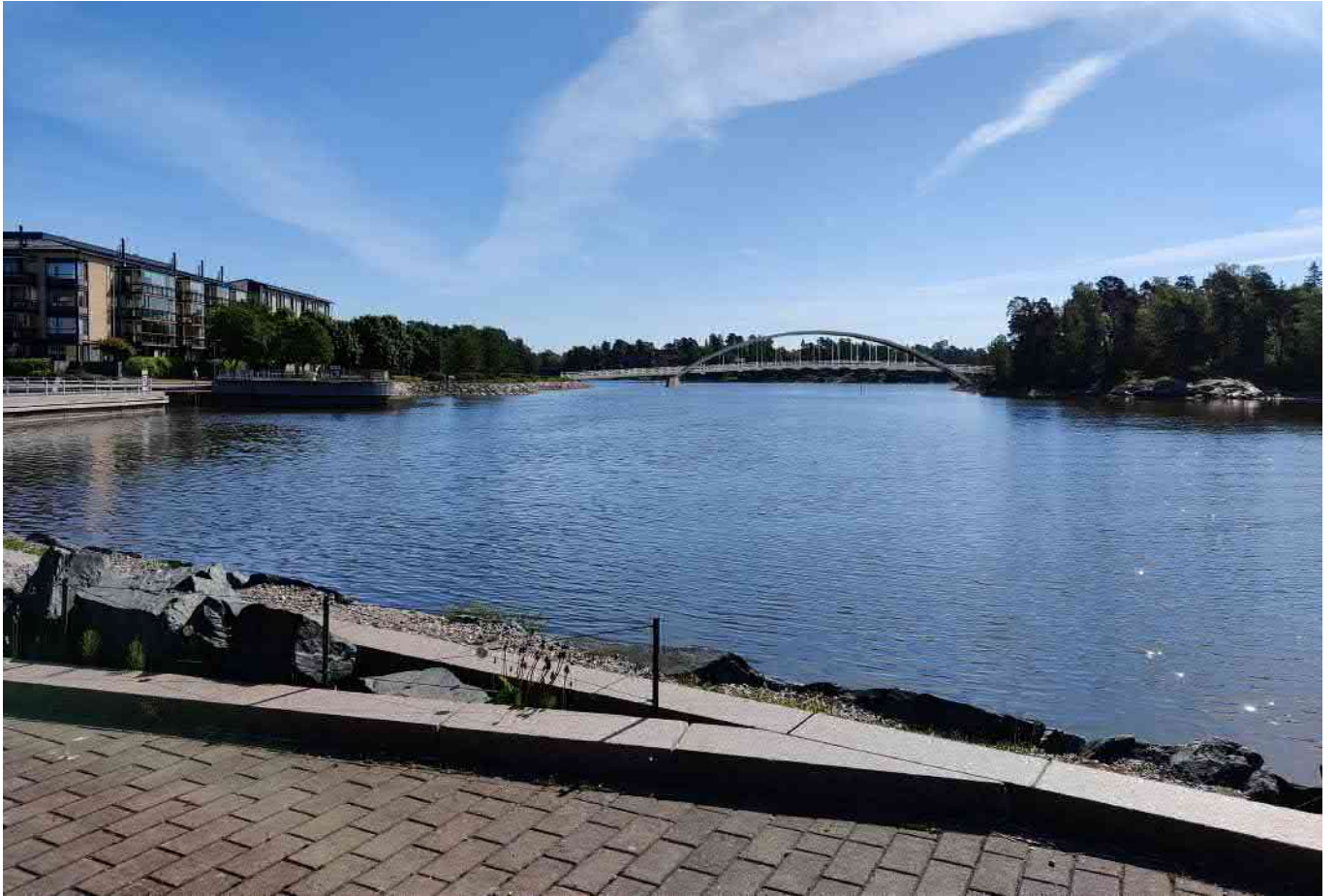
Kuva 25. Silta (VE1B) lännestä katsottuna.
