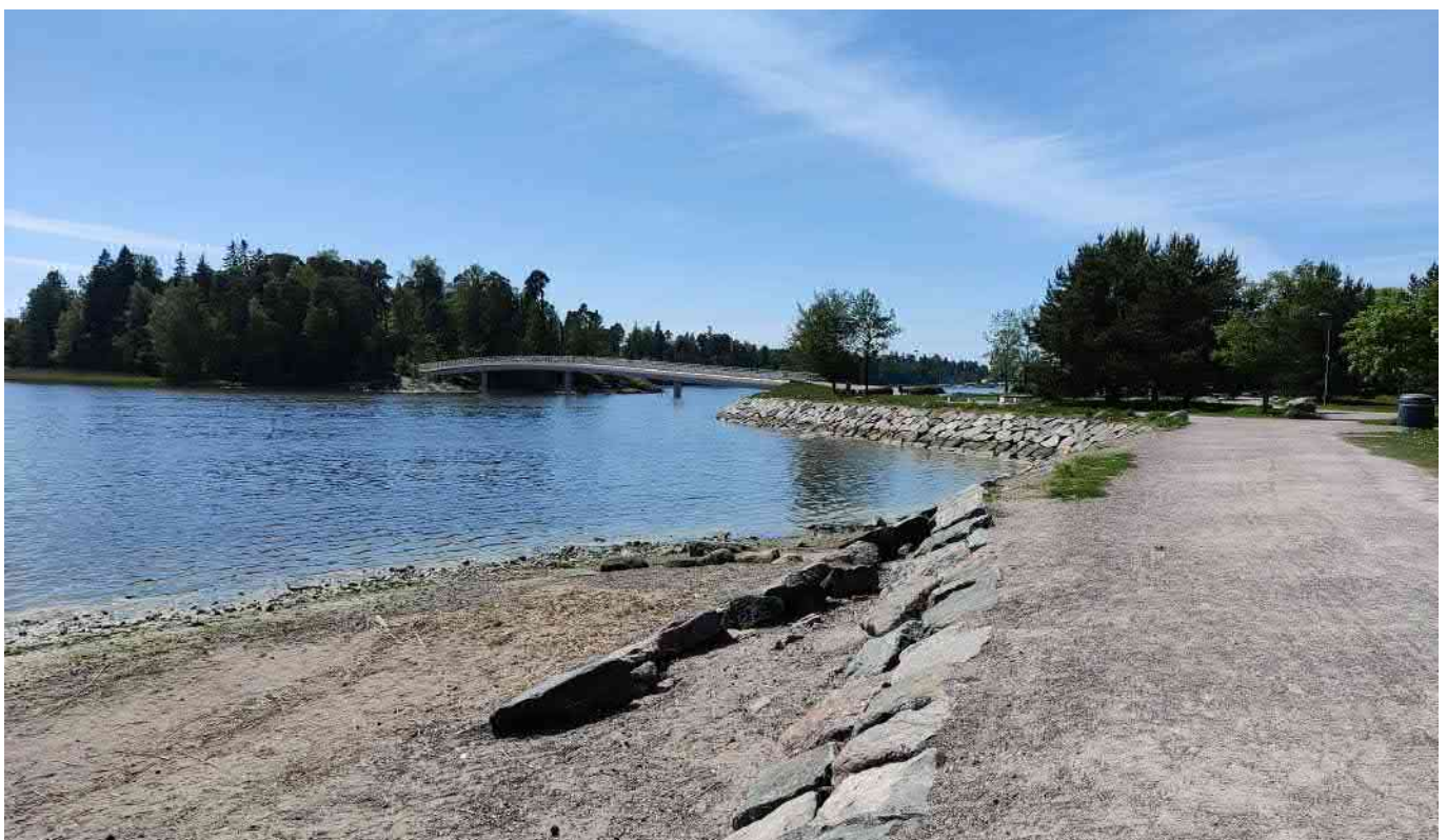
Kuva 23. Silta (VE1A) uimarannalta, idästä katsottuna.
