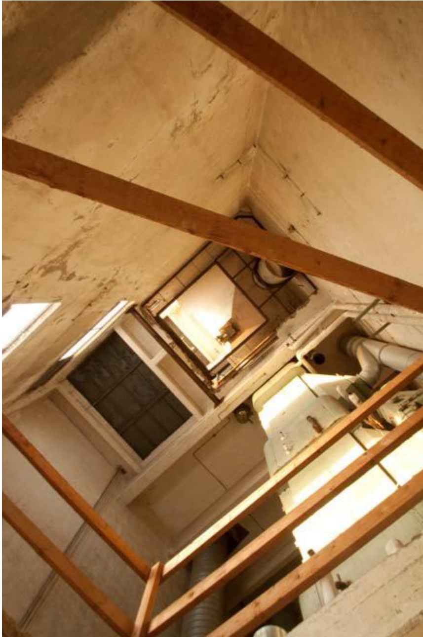
Kuvat 6.43 (vasemmalla), 6-44-6.45 (yllä) Konetornin 6. kerroksesta on purettu osa välipohjaa, tila on avoin kahteen ylemmään kerrokseen. Kuudenteen kerrokseen sijoittuu käytöstä poistettu kuivuri. Valokuvat Talli / MN.
