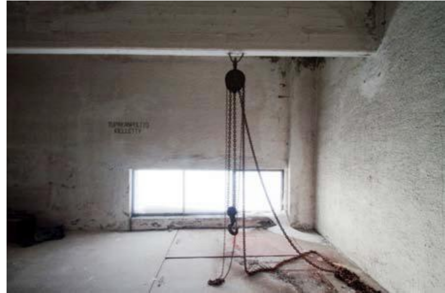
Kuva 6.57 (yllä) Konetornin 12. kerroksen ikkuna ja sen edessä koneiden asennusaukko. Valokuva Talli / MN.
