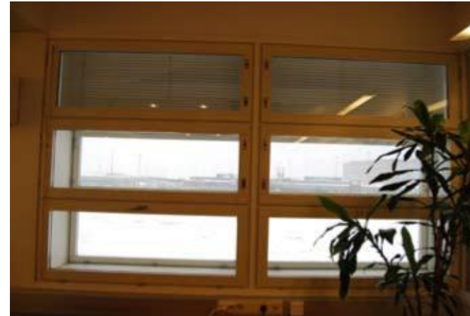
Kuva 6.97 (vasemmalla) Tasovaraston toimistotiloille tyypillinen ikkunarakenne 1980-luvulta.
