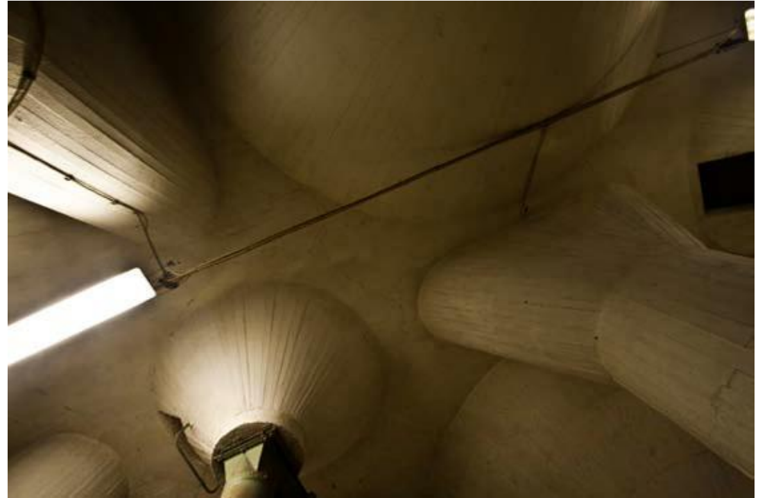
Kuva 6.18 Siilokellarin kattoa. Kuva MN / Talli
