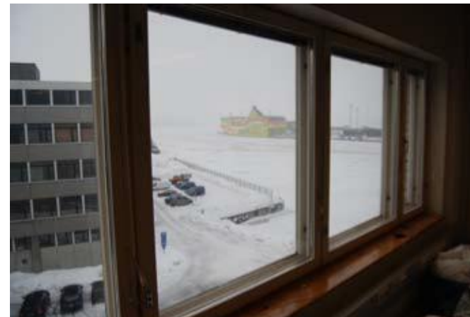
Kuva 6.98 Tasovaraston etelän puoleisessa päädyssä ikkunoissa on erilainen puitejako kuin pitkällä sivuilla.
