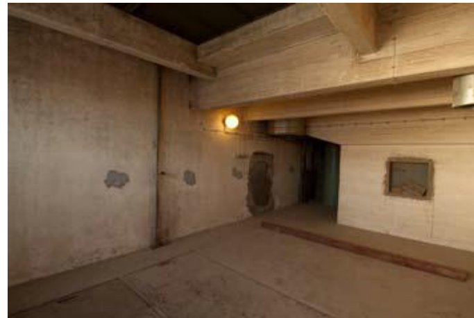
Kuvat 6.43 (vasemmalla), 6-44-6.45 (yllä) Konetornin 6. kerroksesta on purettu osa välipohjaa, tila on avoin kahteen ylemmään kerrokseen. Kuudenteen kerrokseen sijoittuu käytöstä poistettu kuivuri. Valokuvat Talli / MN.
