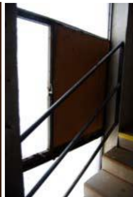
Kuvat 6.21-6.23 (vasemmalla) Porrashuoneen teräsra- kenteinen ikkunaseinä ja sen yksityiskohtia.
