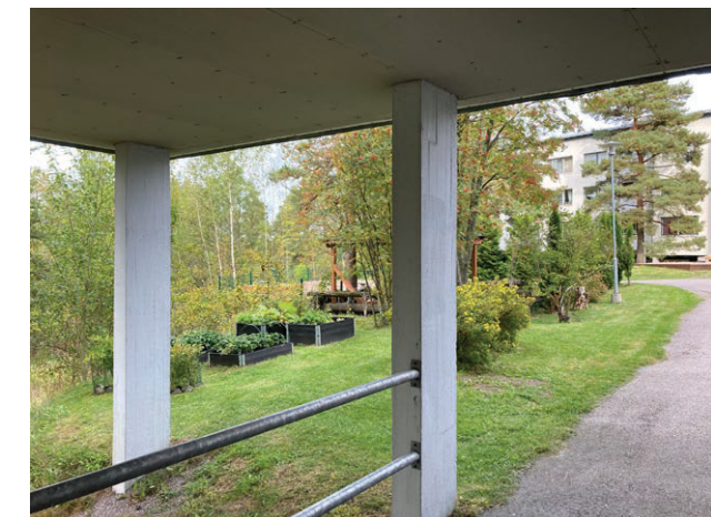
Esimerkki rakennuksen alta pihalle kulkevasta huoltoyhteydestä Siilitie 20, Länsi-Herttoniemi
