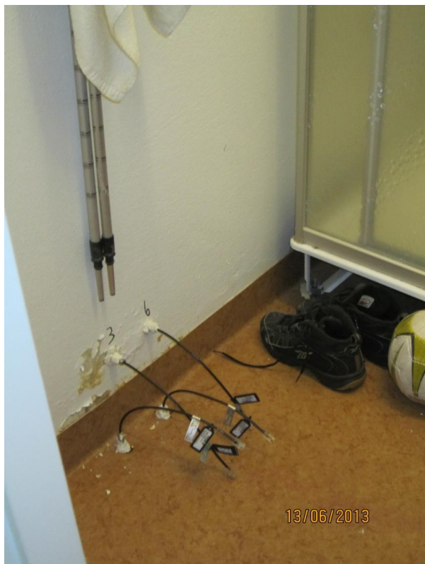
Kuva 2. Opettajan suihkutilan puolelta tehtiin väliseinään sekä lattiaan porareikämittaus
