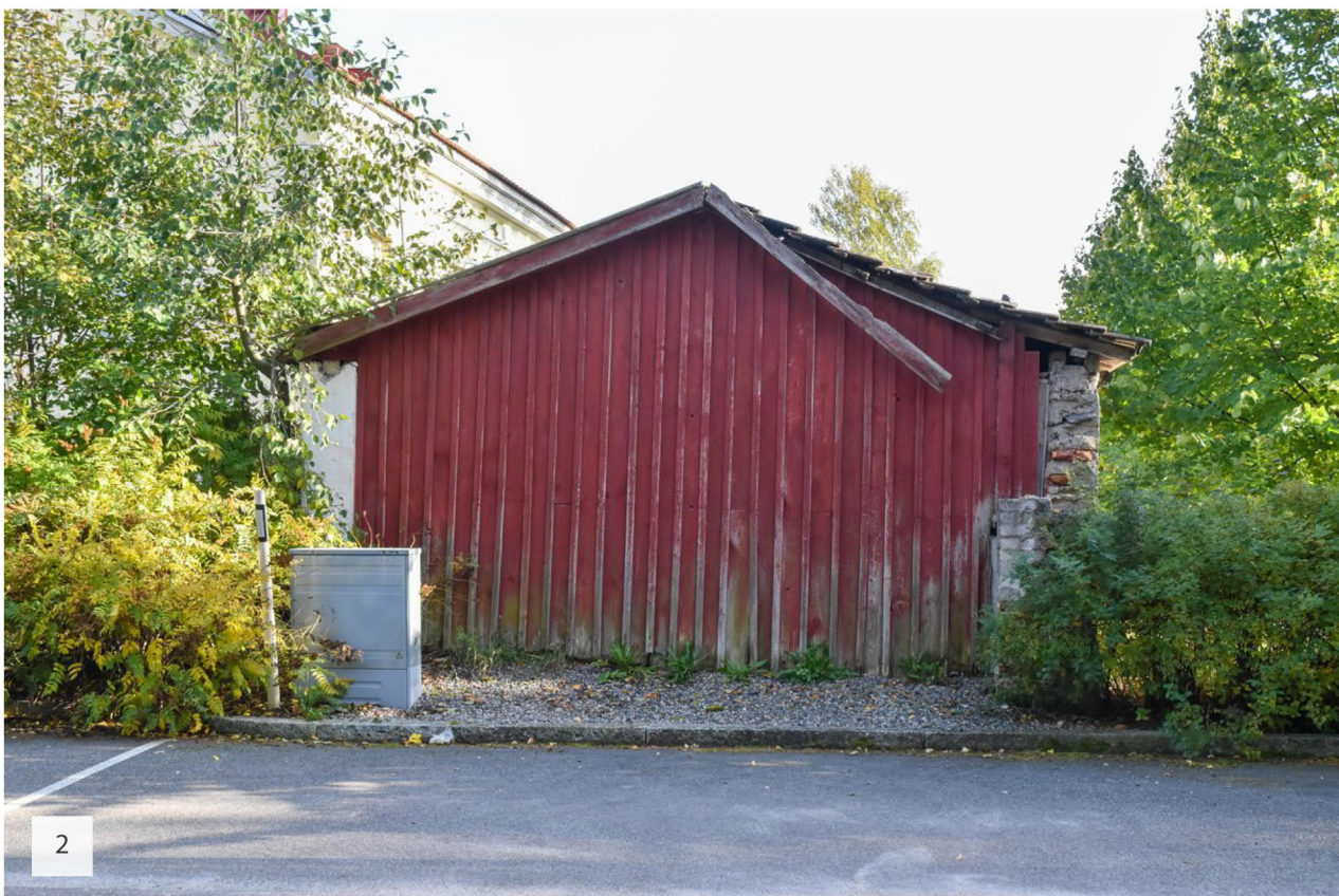
Vaja pysäköintipaikalta kuvattuna. Kuvissa näkyy, että kaakonpuoleinen seinä on muurirakenteinen - vaja oli osa sittemmin purettua tallirakennusta. Kuva 1: OR. Kuva 2: SL.
