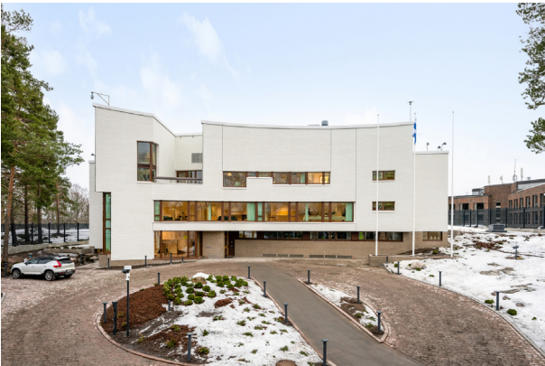
Rakennuksen edustalla on saattoliikennettä varten suuri kääntöympyrä. Tontin kadun ja puiston vastaisilla reunoilla on säästetty vanhoja havu- ja lehtipuita. Kuva: Zentuvo Finland Oy
