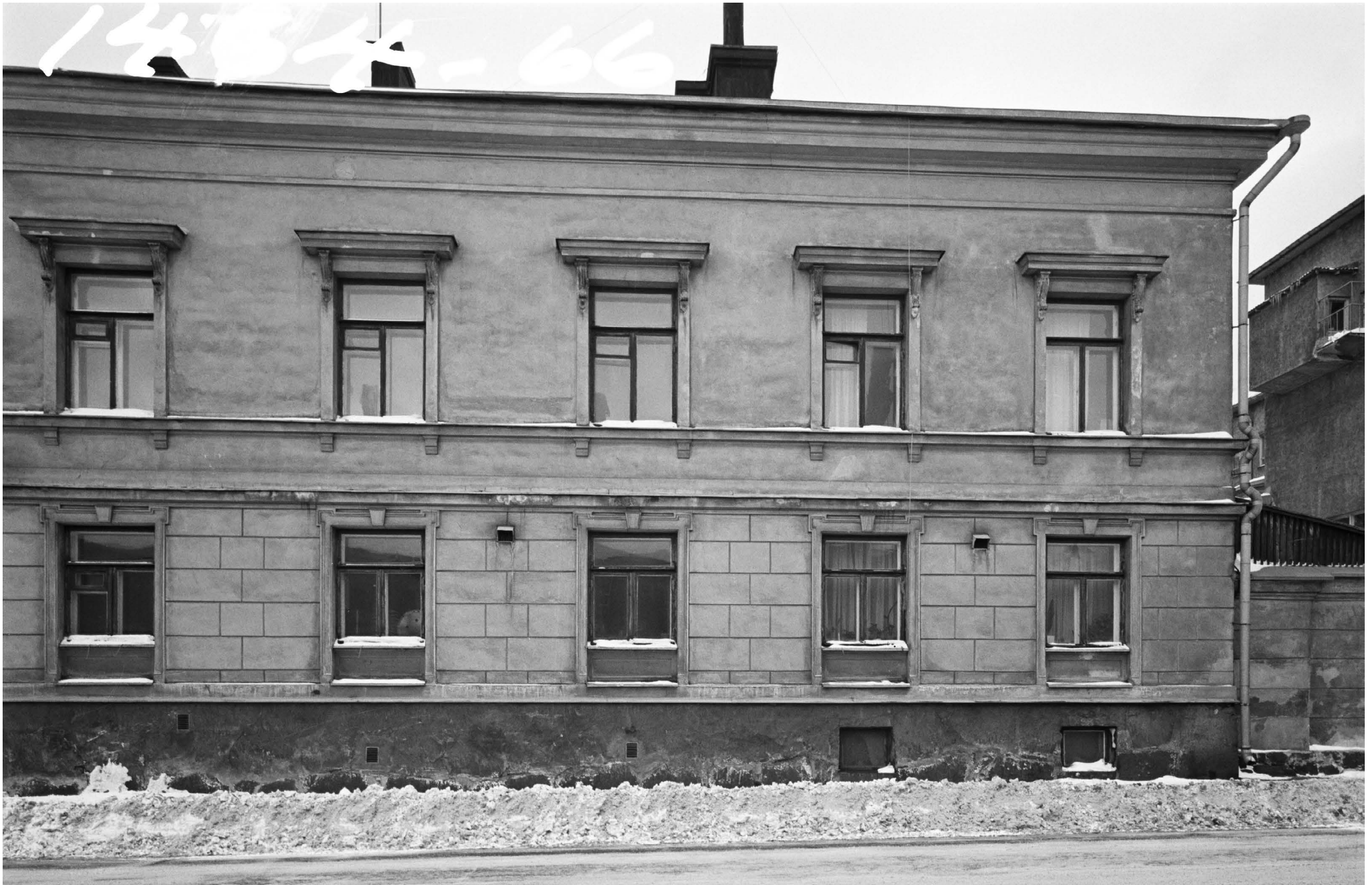
Päärakennuksen katujulkisivu. Valokuva ajankohta 1950- tai 1960-luvulla. HKM. Kuvassa näkyvät hyvin 2. kerroksen ikkunoiden fortuskat, ts. tuuletuspuitteet. Lohkokivisokkeli on ainakin osittain rapattu ja kellariin on avattu muutamia ikkunoita ja tuuletusaukkoja.
