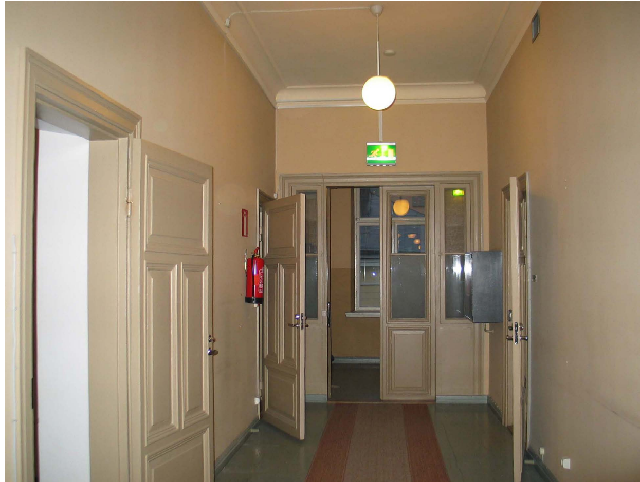
Peiliovia, käytävä 209, kuva vuodelta 2007
