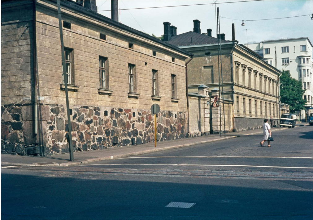
Entisen leipomon ja lasarettirakennuksen katujulkisivu, kuva vuodelta 1967, Constantin Grünberg. HKM. Valokuvan perusteella kuluneen julkisivupinnan väritystä ei voida tarkkaan päätellä, mutta näyttää siltä että ikkunakehykset on maalattu lähes samaan sävyyn kuin julkisivut. Ikkunat on maalattu tummavahalla ruskealla sävyllä.
