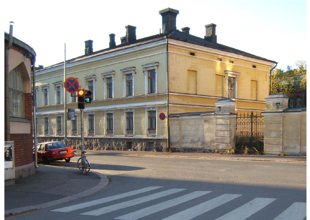
Katujulkisivu ja itäpääty vuonna 2007.
