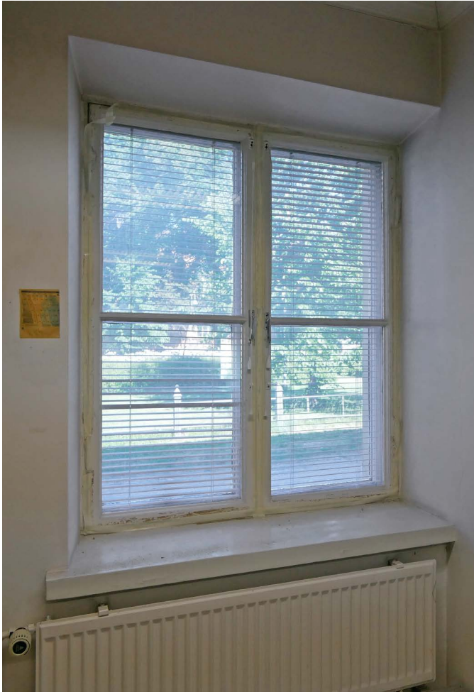
Ensimmäisen kerroksen pihanpuoleinen ikkuna on muodoltaan neliöminen, h. 103-104. Kadun puoleisia ikkunoita suurennettiin 1880-luvulla. Uusissa ikkunoissa oli T-karmi.
