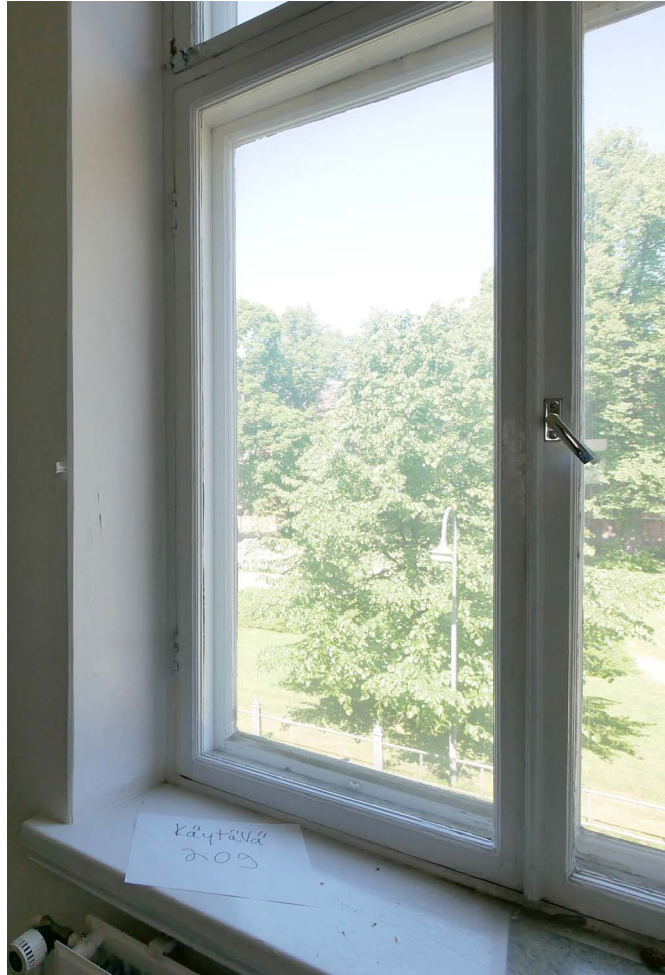
Toisen kerroksen ikkuna pihan puolella, h. 205.
